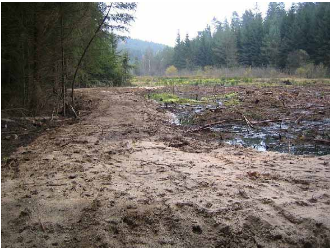
Grabenverfüllung und Räumung des Fichtenbestandes
