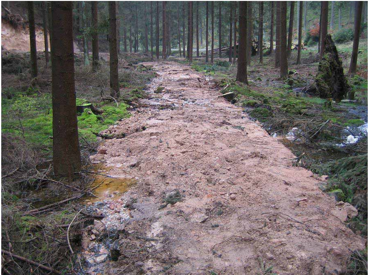
Grabenverfüllung unmittelbar außerhalb des NSG, Durchführung in 2007
