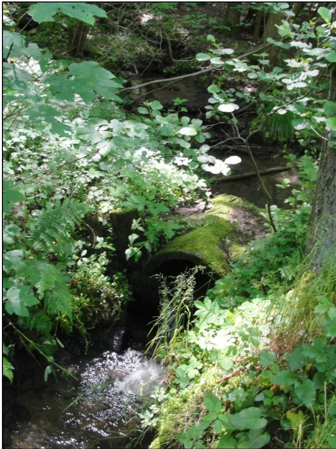
Foto 13: Verrohrter Teilabschnitt des Meerbaches westlich der Gronauer Straße (Vogt-Rosendorff, 08.06.2016).
