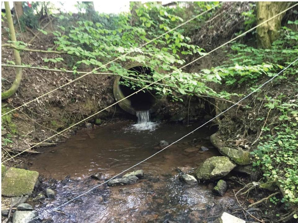
**Abbildung 18: Brom-3, Auslauf der unteren Verrohrung, zum Erhalt als Krebsbarriere gegen zukünftig evtl. aus der Weschnitz in den Brombach aufsteigende Signalkrebse vorgeschlagen. Photo R. Hennings, IMG\_0956, 9.5.2016.**
