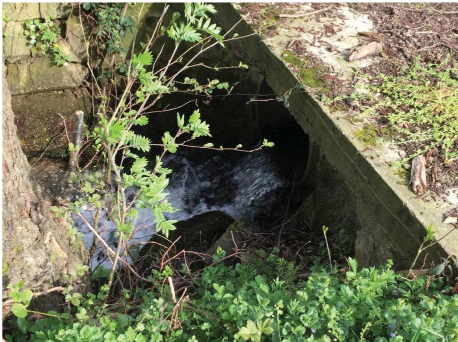
**Abbildung 14: Fahr-2, typische Durchgängigkeitsmaßnahme Rohrdurchlass mit ausgespültem Absturz; im Bachneunaugenbestand EZ B und Groppenbestand EZ C im Fahrenbach. Photo R. Hennings, IMG\_0351, 22.04.2016.**
