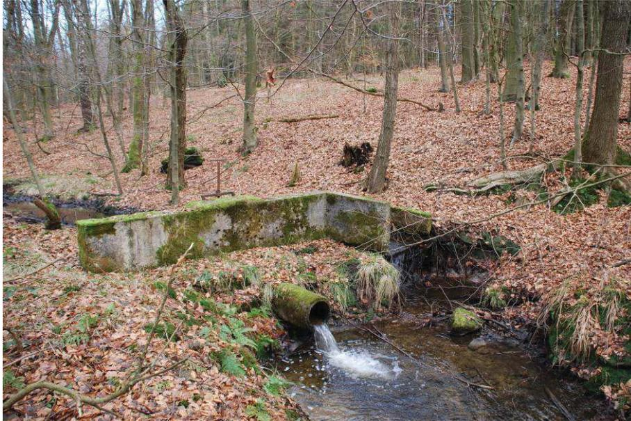
**Abbildung 3: Umläufiges Ausleitungsbauwerk oberhalb der ehemaligen Fischteiche am westlichen Elsterbach-Quellarm**
