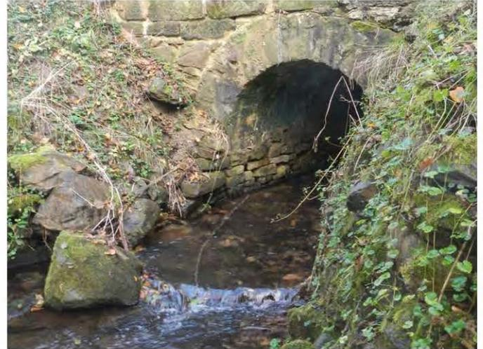
**Bild 2:** Nieste bei Station km 18+500: Eine Brücke aus Natursteinen quert das Gewässer. Am Ende der Massivsohle hat sich eine kleine, aber nicht relevante Schwelle entwickelt.
