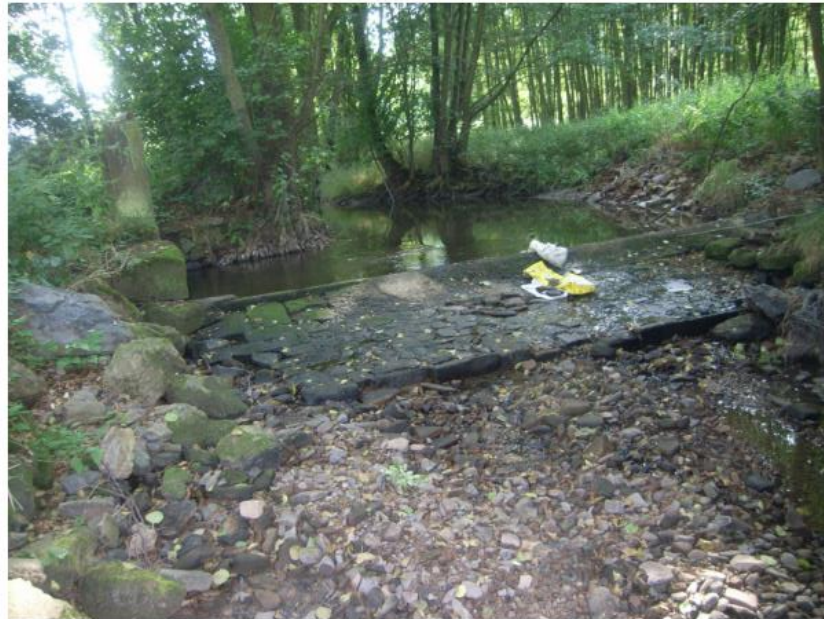
oben: Blick gegen die Fließrichtung auf die Wehranlage der Obermühle in Remsfeld (Foto: UIH)
