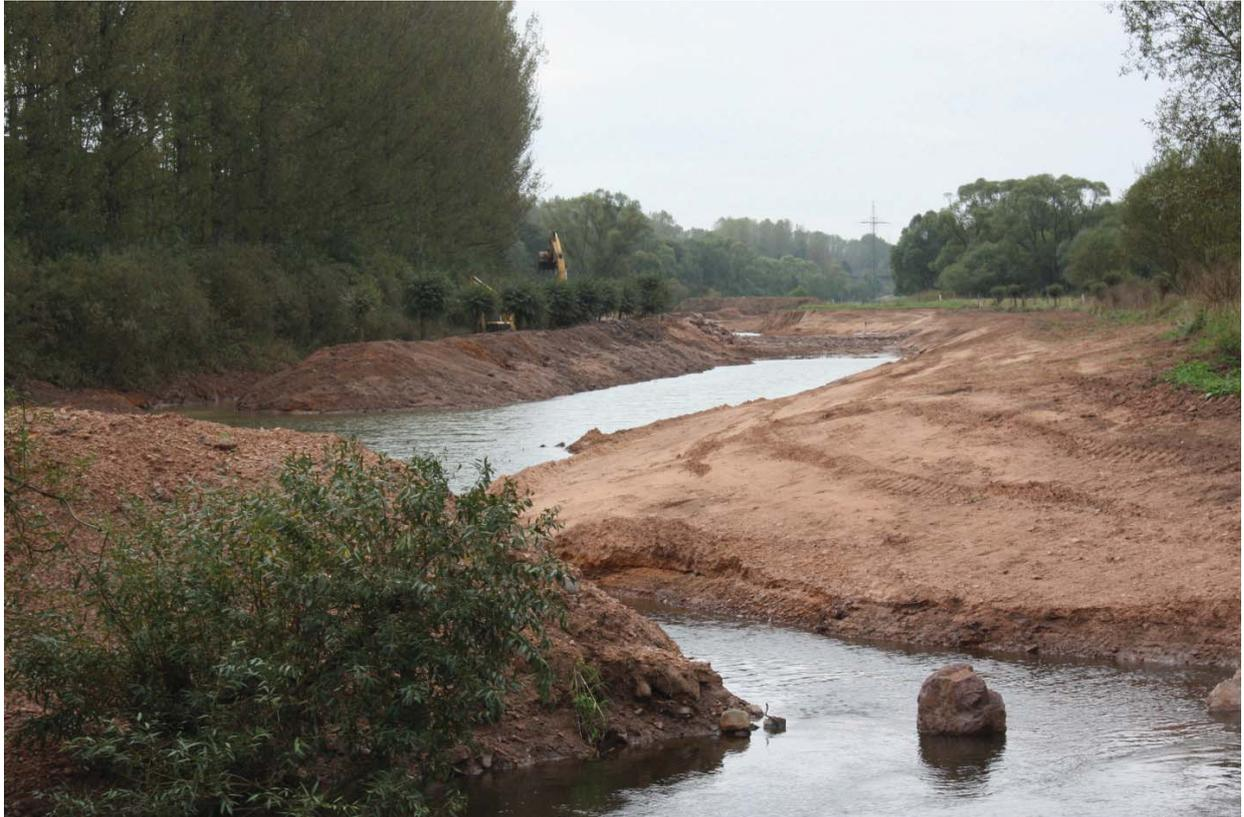
Geglückte Renaturierungsmaßnahmen im östlichen Teil des NSG „Alte Fulda bei Blankenheim“: Anlage eines Altarmes mit Stillwasserbereichen, Rohboden- und Kiesflächen als potentielles Bruthabitat für Flußregenpfeifer und Flußuferläufer
