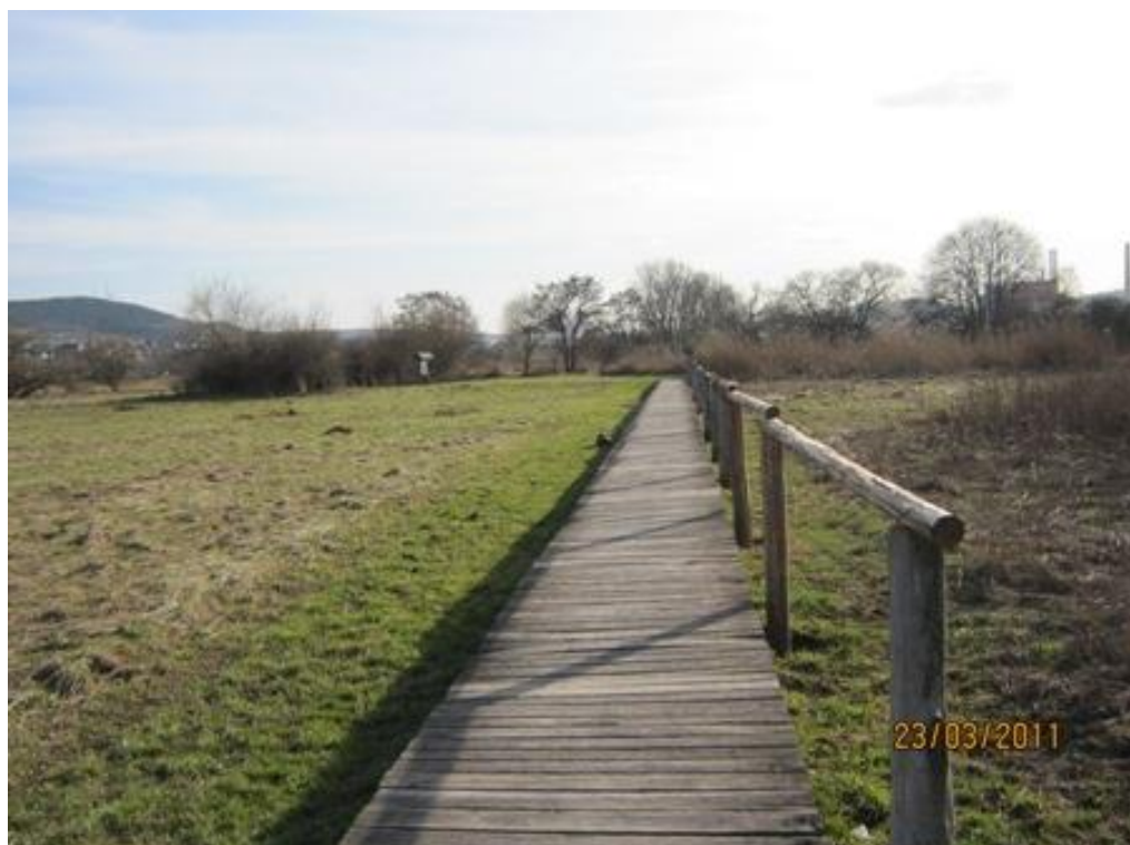
Abb. 10 und 11: Teil- Rückbau des Bohlenstegs zur Beruhigung des Vogelschutzgebietes.
