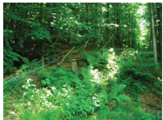
Foto 1 : Beseitigung von altem Knotengeflechtgatter
