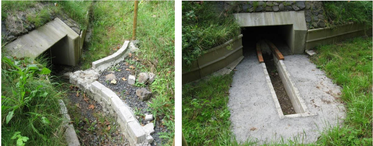
Abbildung 7: Eingangsleitelemente, die die Amphibien in die Tunneleingänge lotsen sollen.
