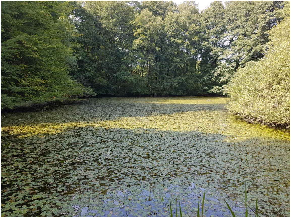
Abbildung 19: Blick von der Stauwurzel in Richtung Damm. Der Mönch ist in Bildmitte schwach erkennbar. Aufnahmedatum: 27.08.2018)
