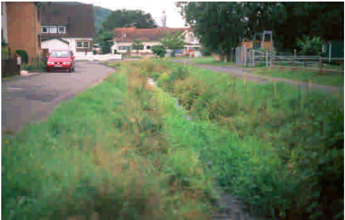
Abb. 4.128: Gepflastertes Mutterbett im Mündungsbereich in Veckerhagen
