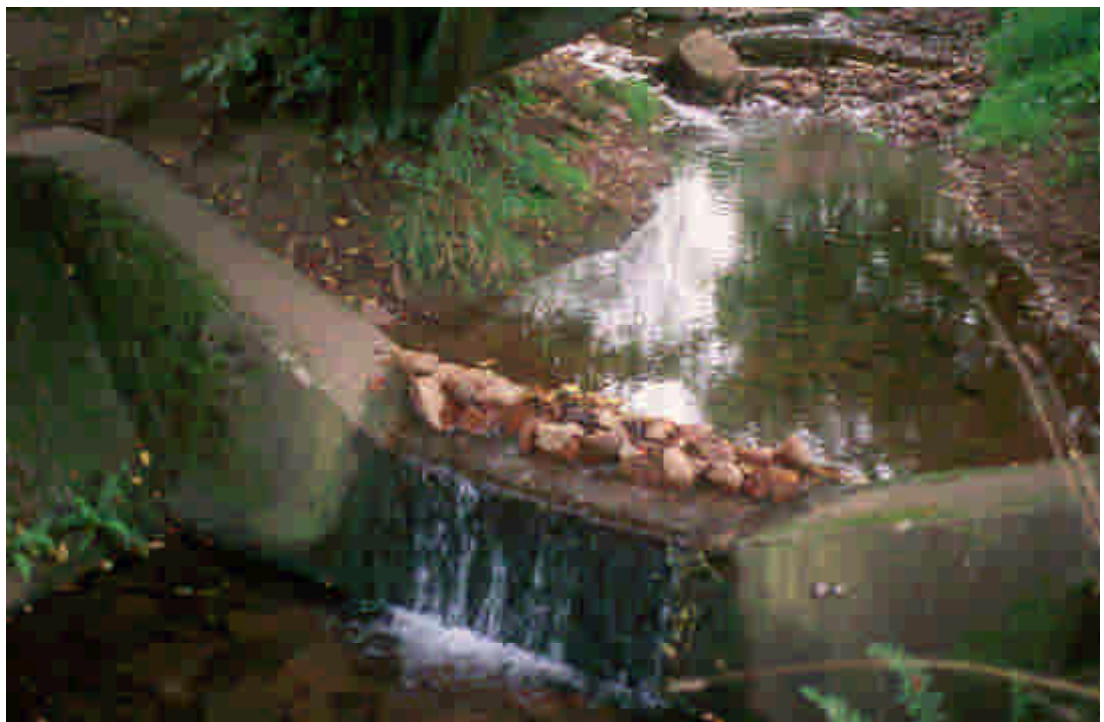
Abb. 4.125: Zahlreiche Sohlenabstürze unterbinden die Aufwanderung
