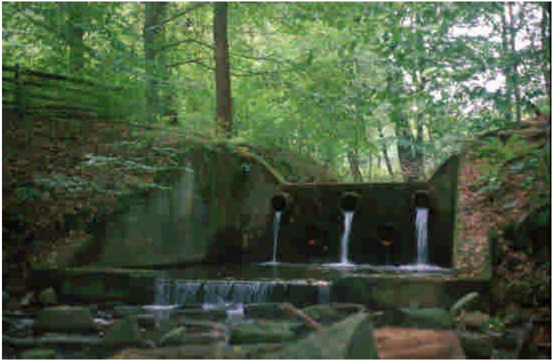
Abb. 4.127: Stellenweise unterbrechen Sohlenabstürze den Bachlauf des Hemelbaches
