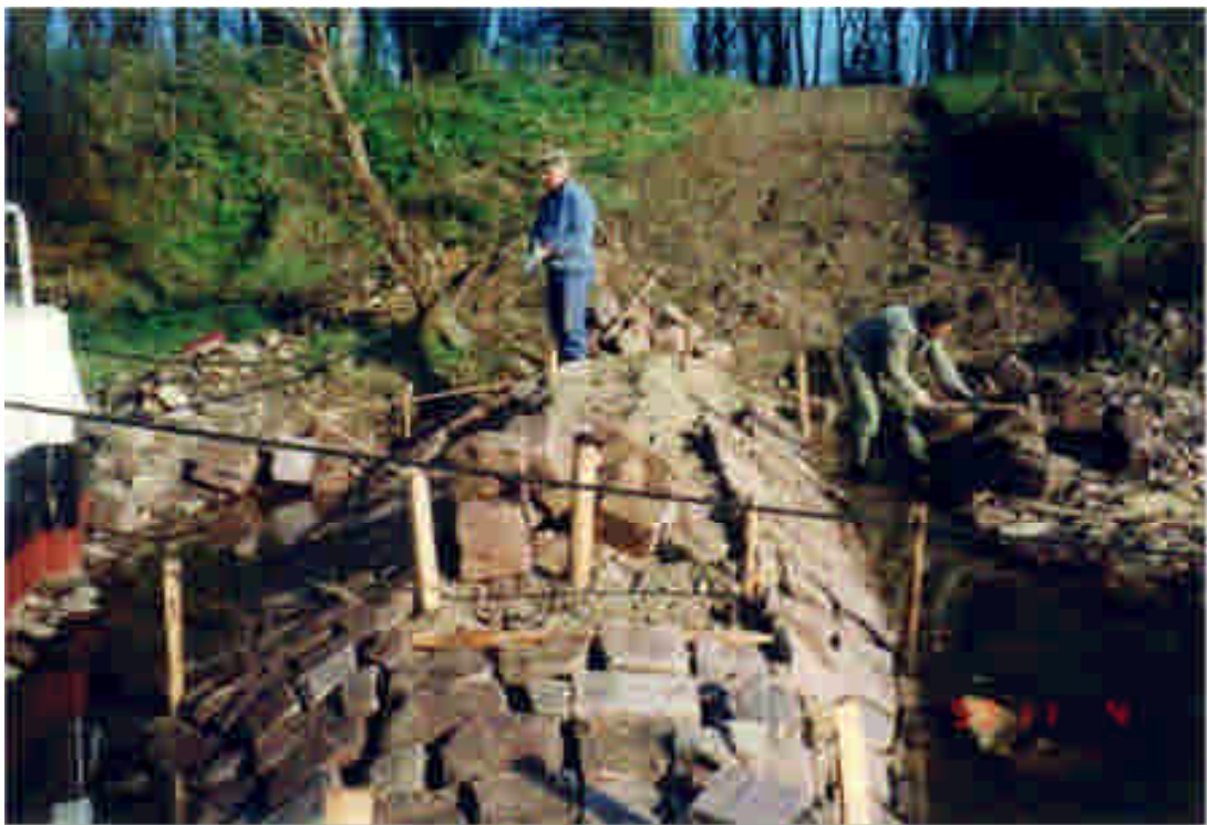
Abb. 4.119: Instandsetzung der Buhnen in der Oberweser (Photo: Wasserstraßenverwaltung)
