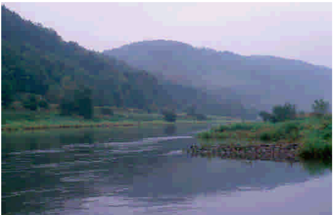
Abb. 4.122: Typischer Aspekt der hessischen Oberweser mit einseitig angeordneten Bühnen und vereinheitlichtem Strömungsbild
