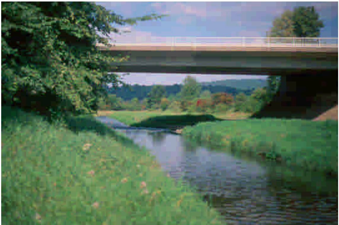
Abb. 4.40: Das ausgebaute Mutterbett der Wehre...
