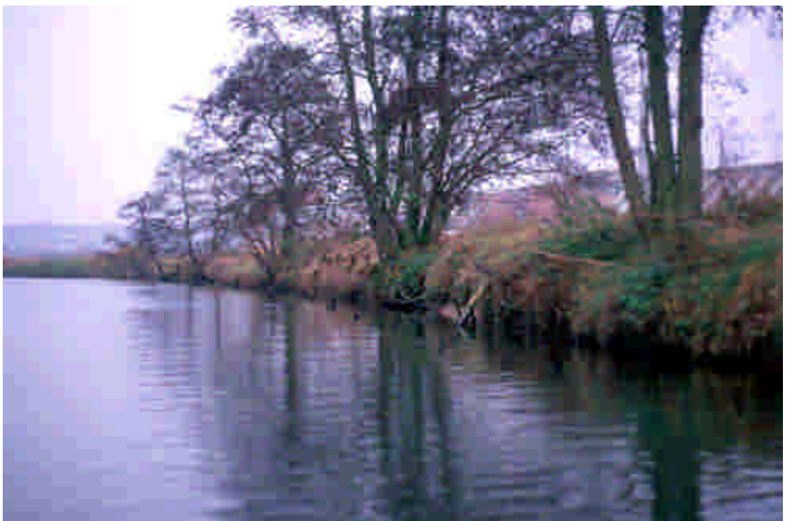
Abb. 4.2: Lediglich Reste von Pfahlreihen weisen auf eine ehemalige Ufersicherung im Staubebereich von Heimbaldshausen hin
