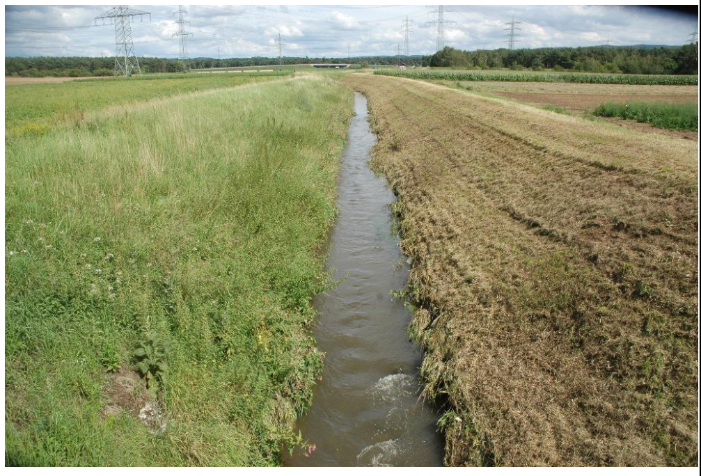
Abb. 5: Probeflä- che Sandbach, nach Ufermahd (Foto: S. Stübing)
