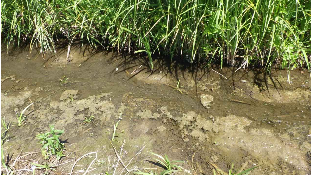
Abb. 6: Erkennbar sind die geringe Wasserführung, starke Verschlammung und das Algenwachstum am Graben (Foto: B. Hill).
