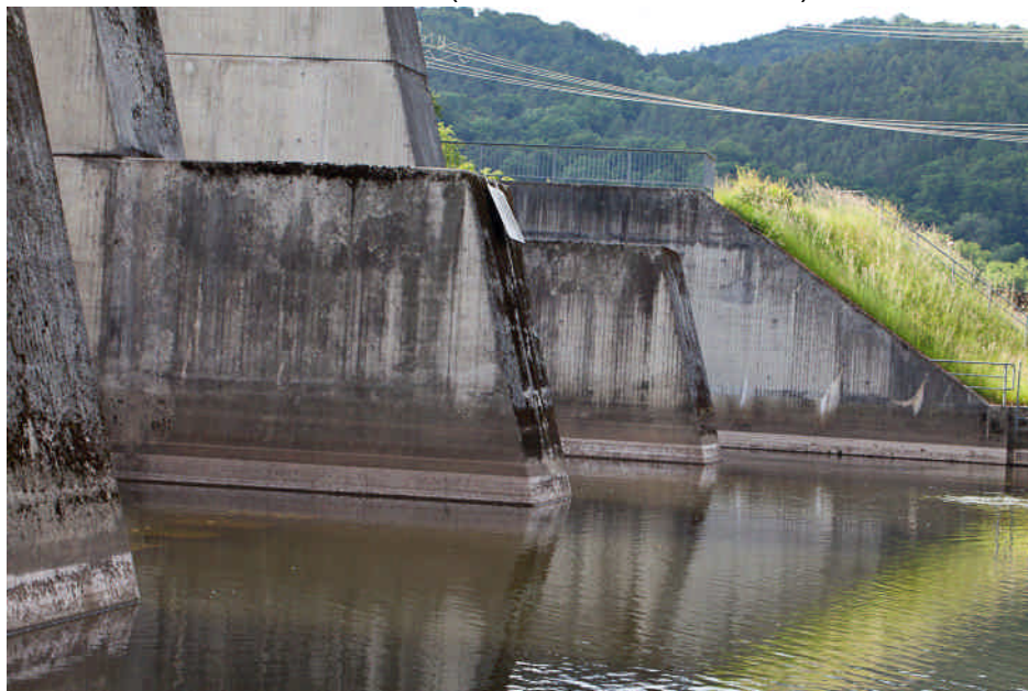
Abb. 45. Entodon schleicheri wächst auf einer Steinböschung unmittelbar im Anschluss an die Betonmauern der Staumauer.
