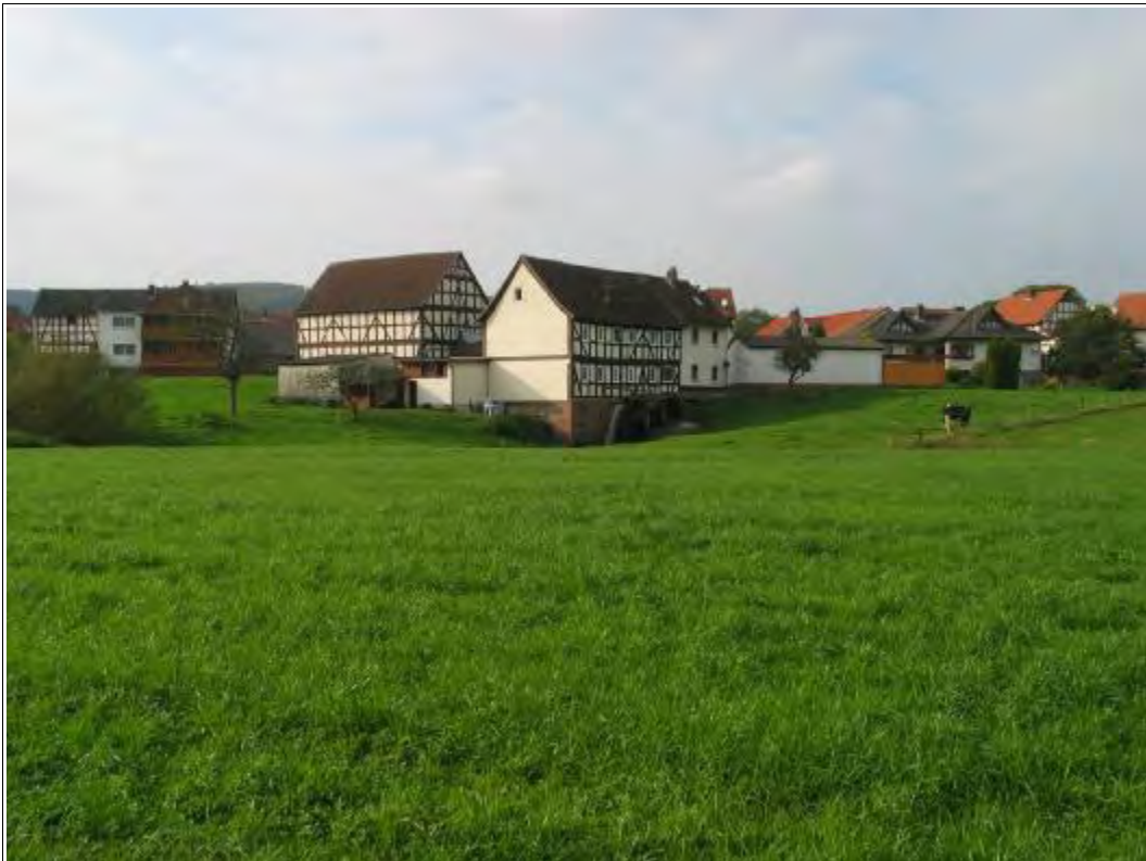
Abbildung 78: Mühle in Bracht. Absturz des Wassers über das Mühlrad, das nicht mehr funktionsfähig ist. Für Fische unpassierbar. Ähnlich stürzt das Wasser auch über das ebenfalls nicht mehr funktionsfähige Mühlrad der Waldmühle zwischen Bracht und Schönstadt.
