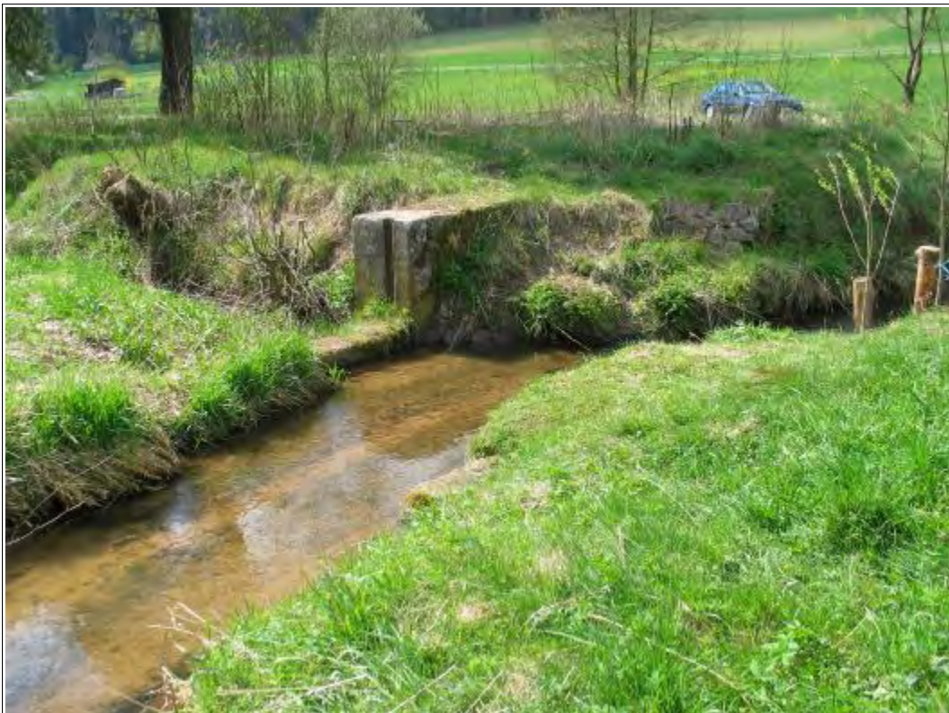
Abbildung 79: Ausleitung in den Mühlgraben unterhalb von Bracht. Das gesamte Wasser fließt nach rechts in den Mühlgraben, der wie der eigentliche Lauf des Gewässers wirkt. Nur bei Hochwasser fließt Wasser in die Ausleitungsstrecke.
