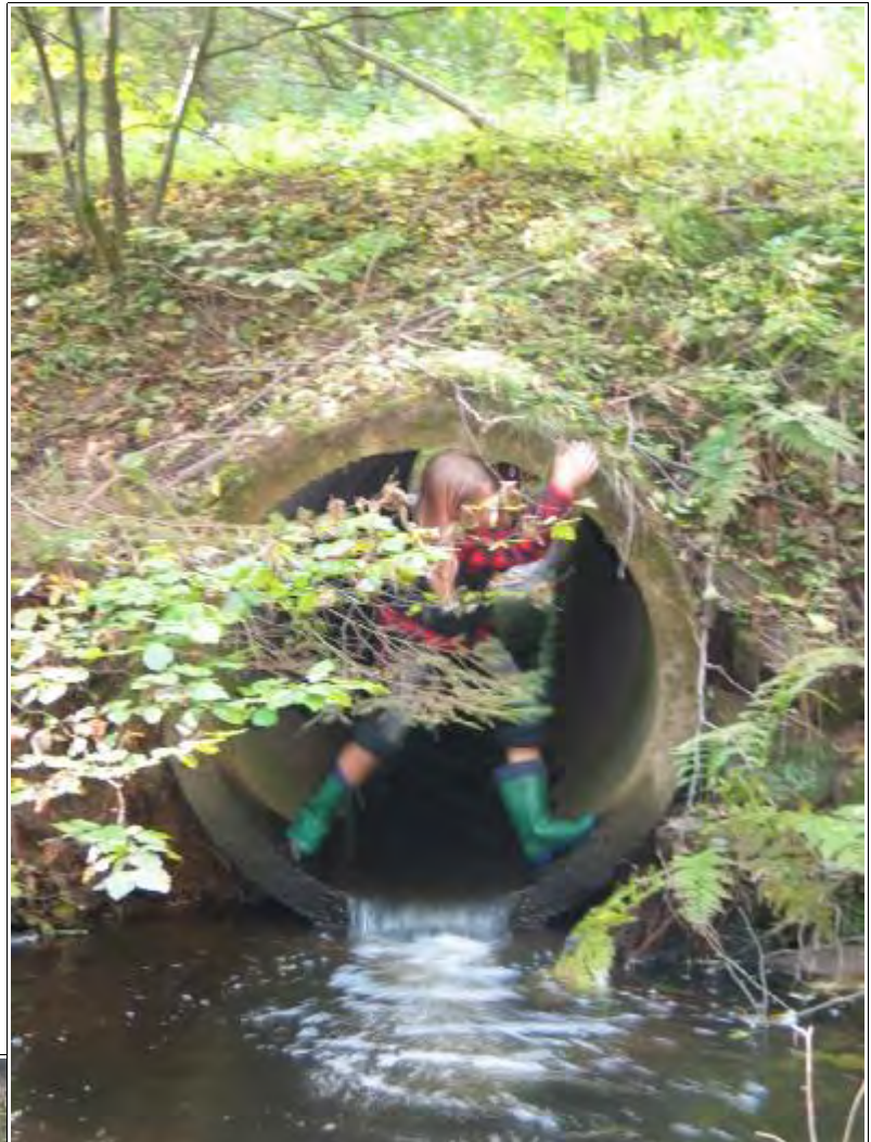
Abbildung 76: Rohr unterhalb des Fröscheteichs als Wanderhindernis. Das Aufwandern von Kleinfischen und Wirbellosen ist durch Höhendifferenz und ohne Substrat im Rohr nicht möglich. Elfjähriges Mädchen als Größenvergleich.
