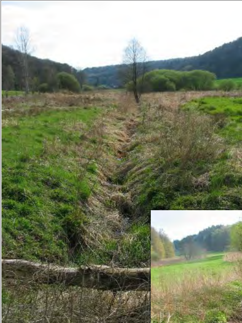
Abbildung 32: Ausleitungsstrecke des oberen 1. Mühlgrabens. Nur Restwasserpflüzen verbleiben im Gewässer.
