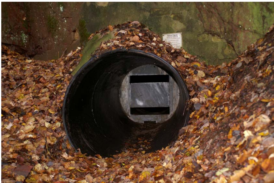
Abb. 7: Stolleneingang des Stollen 3 (S3)
