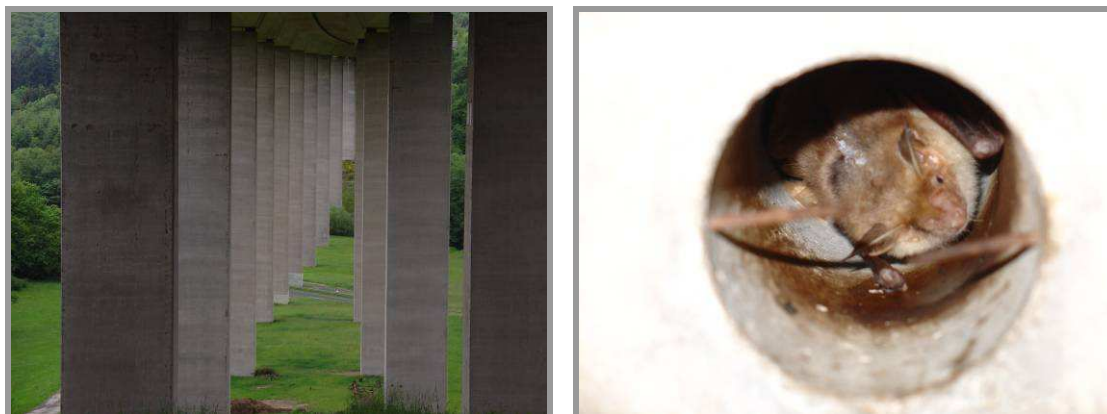
Abb. 8: Lempbachtalbrücke – die Hohlkammer diente während einer Kälteperiode einem besondern weiblichen Mausohr als Ausweichquartier (Fotos: Kathrin Bögelsack).
