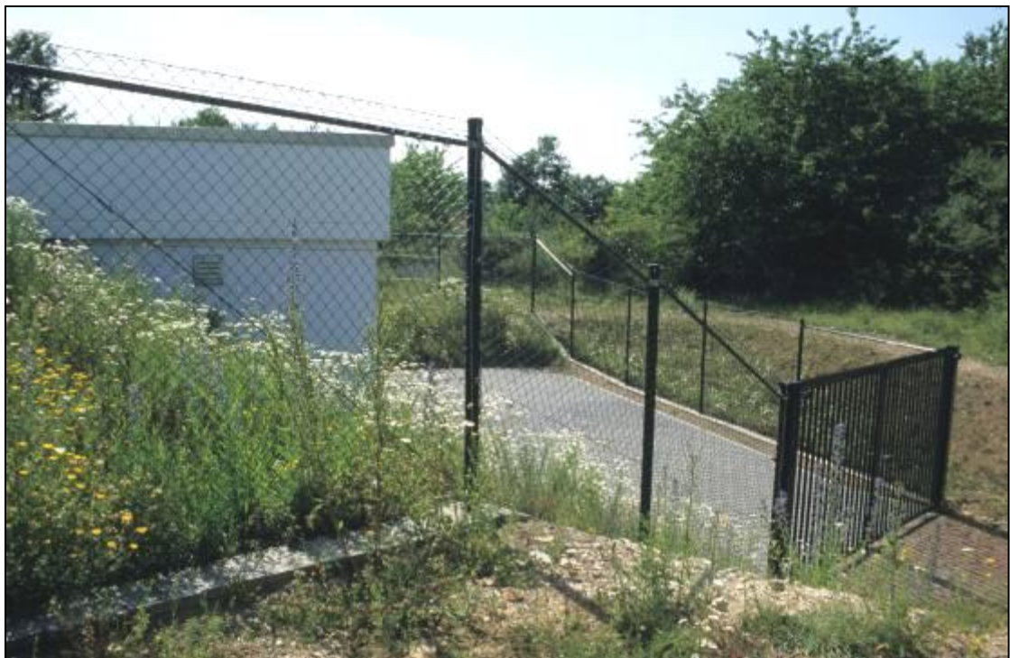
Abb. 14 - Im westlichen Gebietskern wurde die Wassergewinnungsanlage neu ausgebaut (Betongebäude und Verbundsteinpflaster). Innerhalb und außerhalb der Umzäunung entstanden danach arten- und blütenreiche Ruderalfluren warmer Prägung.
