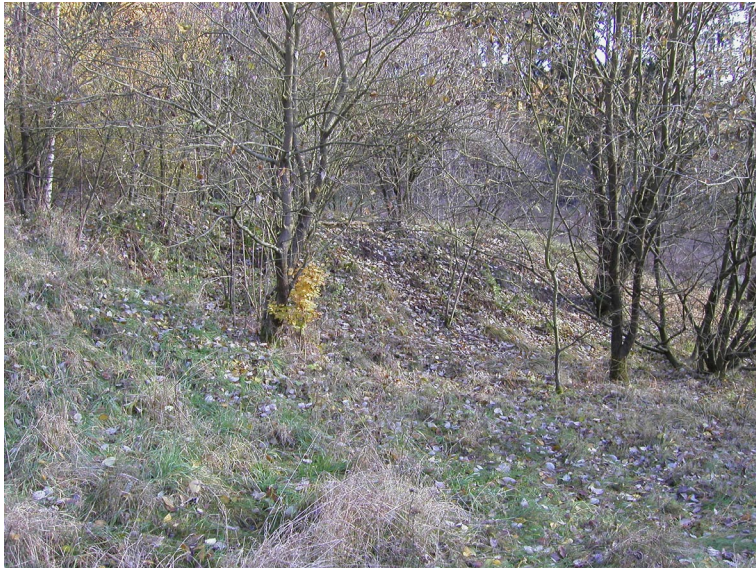
004: Die unvollendete Dammschüttung nahe DQ 3 sollte wieder entfernt werden
