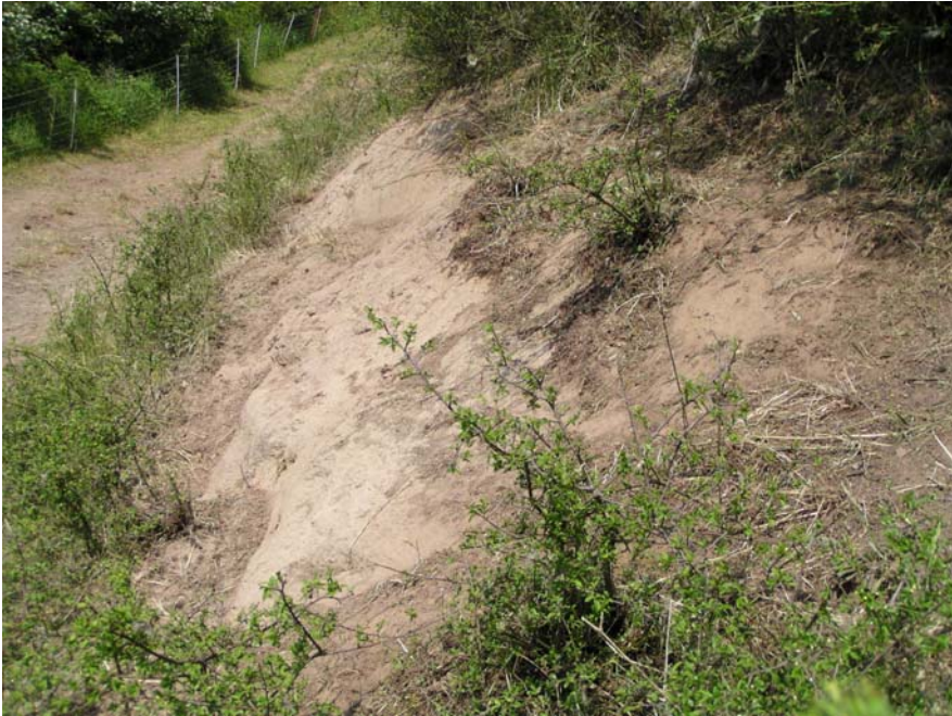
Foto Nr. 21: Erosionsschäden durch Tritt im Bereich der Felspionier-Vegetation (LRT 8230) im Südteil des Gebietes; die erodierten Flächen sind fast vegetationsfrei, gleichzeitig droht vom Rand her nach wie vor Verbuschung; Aufnahmedatum: 11.05.2006, Blickrichtung: West-Nordwest
