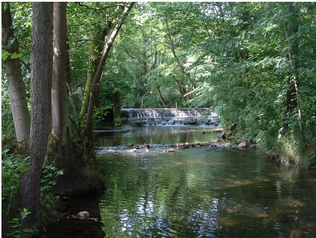
Abb. 8.2.1.1.2: südlich von Birstein erfordert kostenintensive Sanierungsmaßnahmen ...
