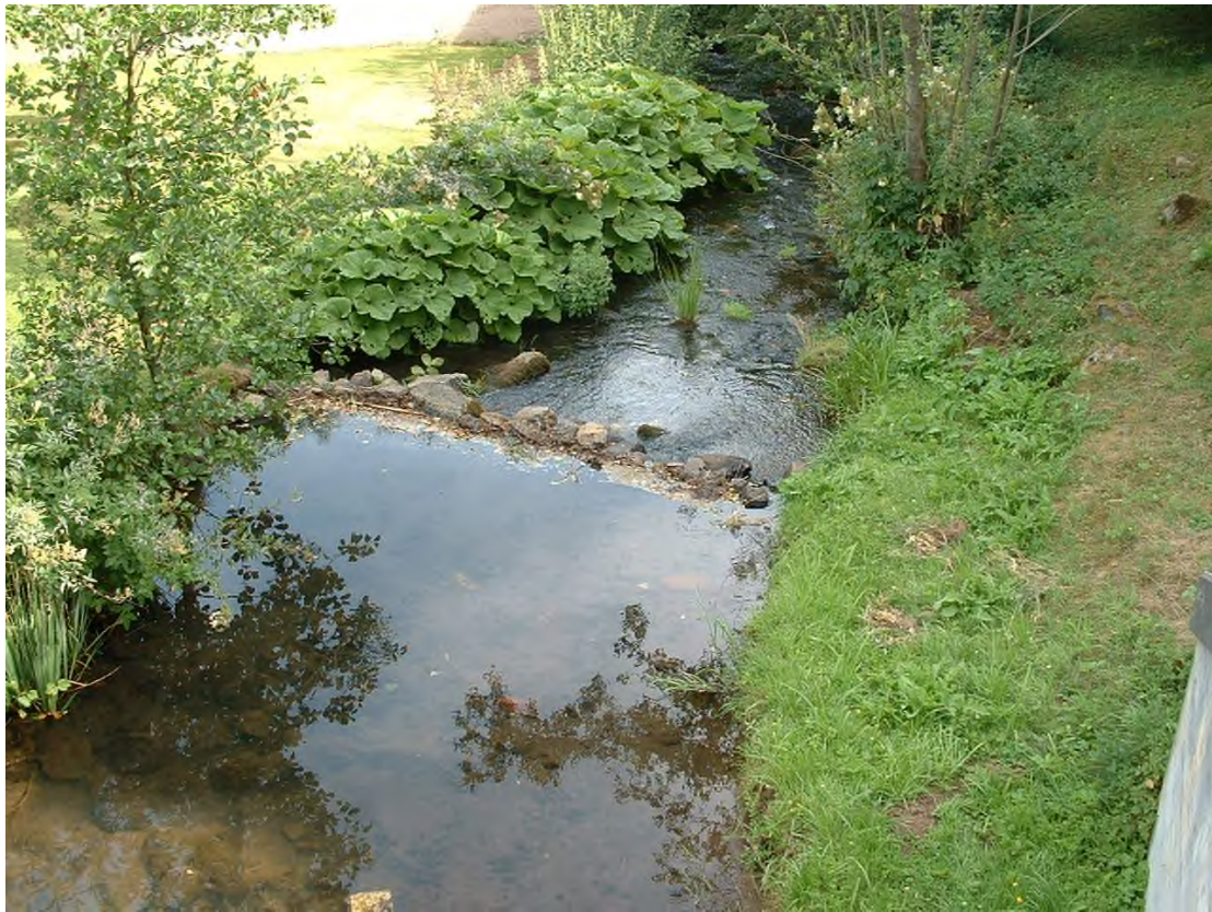
Abb. 8.2.1.1.3: .. hingegen ist durch das Auflösen kleinerer Steinriegel die Wiederherstellung der Durchwanderbarkeit einfach zu erreichen.
