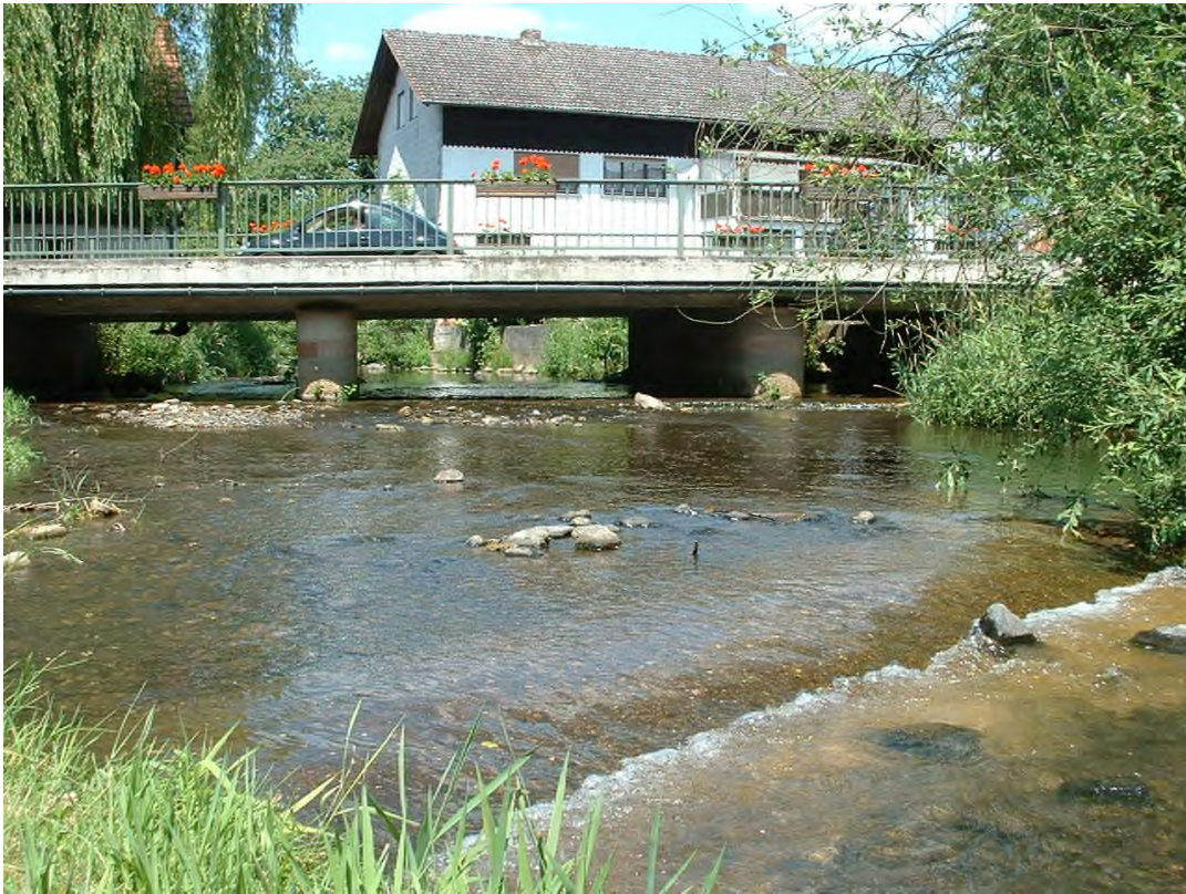
Abb. 8.2.3.1.2: Massivsohle mit Substratauflage im Siedlungsbereich von Hellstein.
