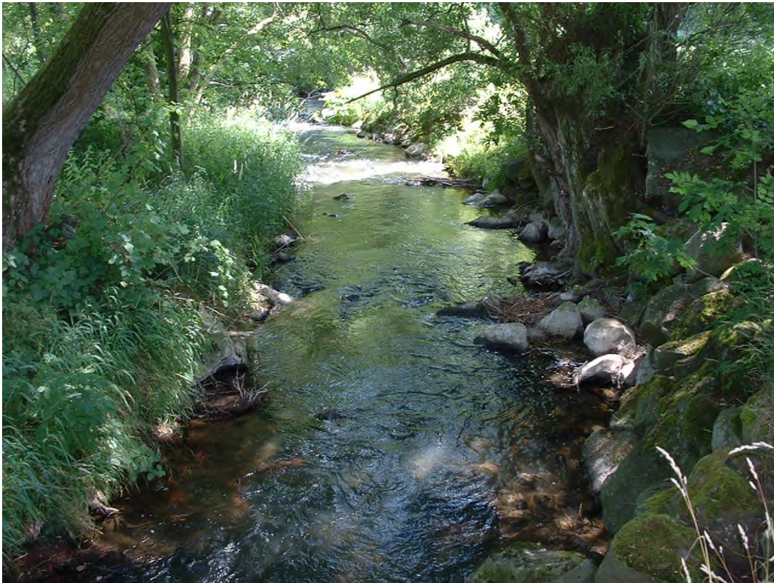
Abb. 8.2.3.2.1: Steinschüttungen und -stickungen im Uferbereich fixieren den Reichenbach südlich von Hellstein.
