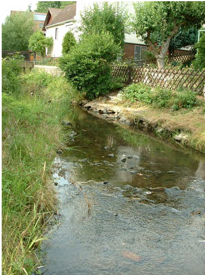
Abb. 8.2.3.2.2: In Birstein dient der Uferverbau dem Schutz der bebauten Fläche. .
