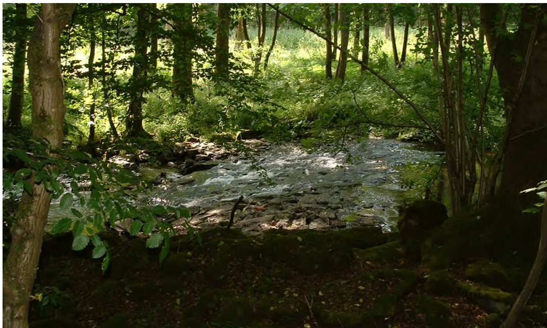
Abb. 8.2.3.1.1: Reichenbach - flach überströmte Rampe mit massivem Steinsatz im Waldbereich.
