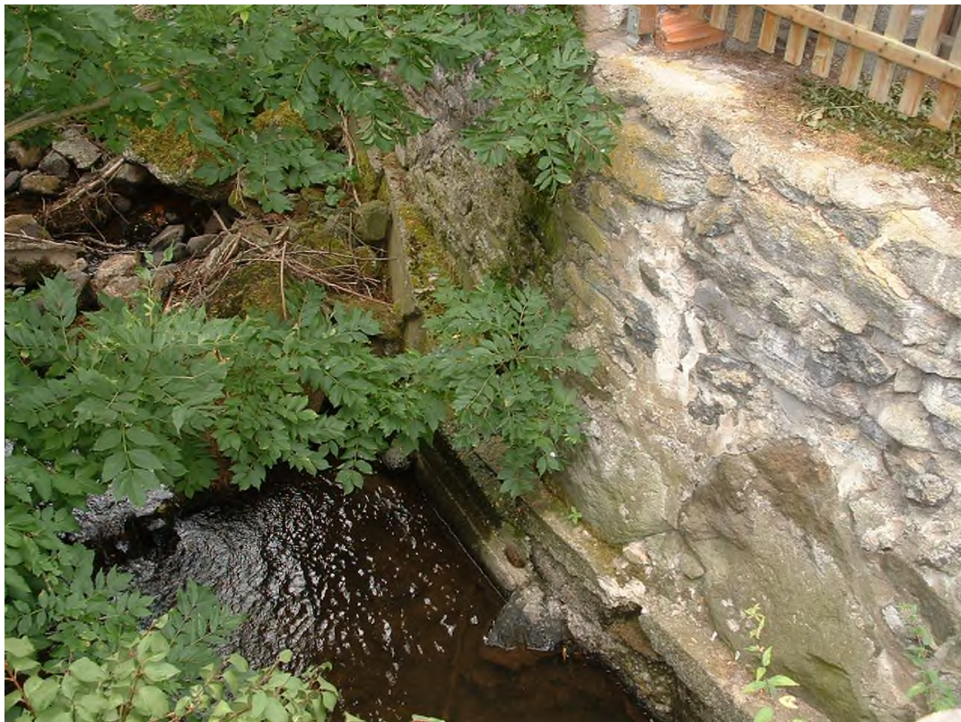
Abb. 8.2.3.1.1: Ürzeller Wasser - massiverer Sohlen- und Uferverbau im Bereich Obere Dielmühle.
