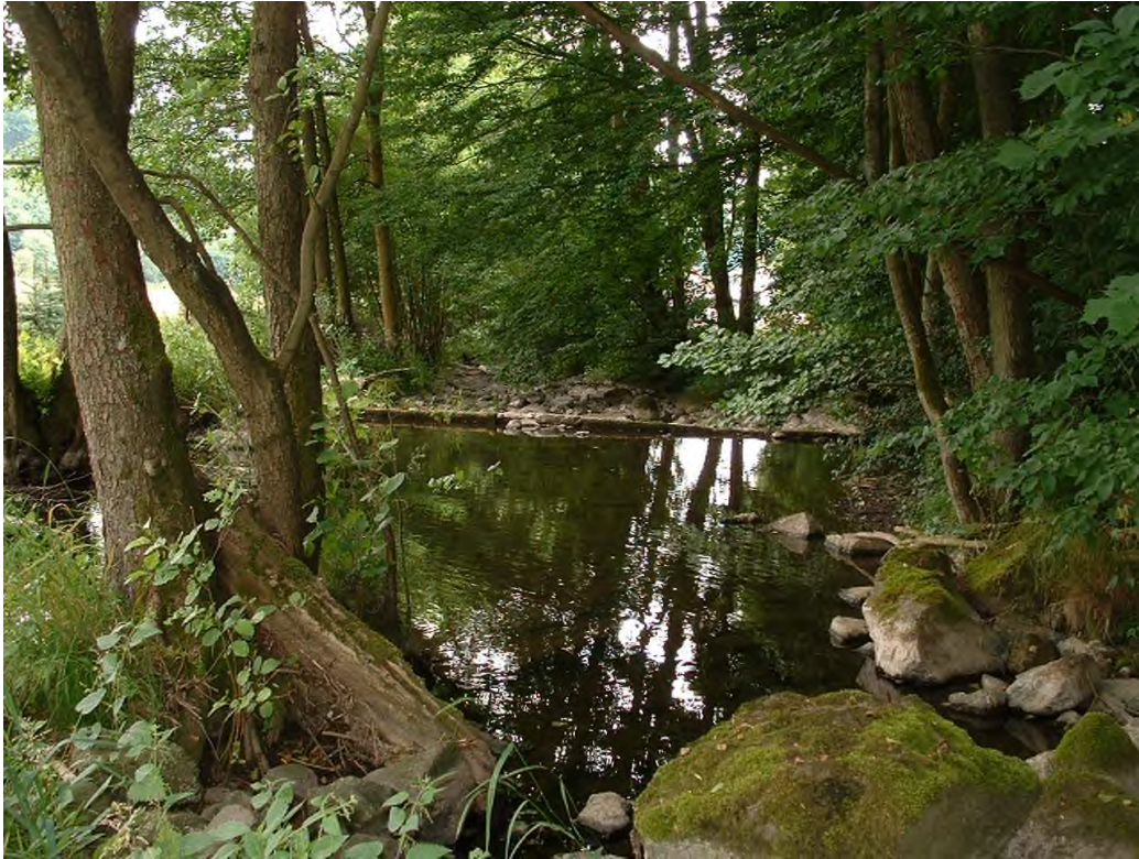
Abb. 8.2.1.1.1: Bei dem Entnahmebauwerk der Waltersmühle besteht ...
