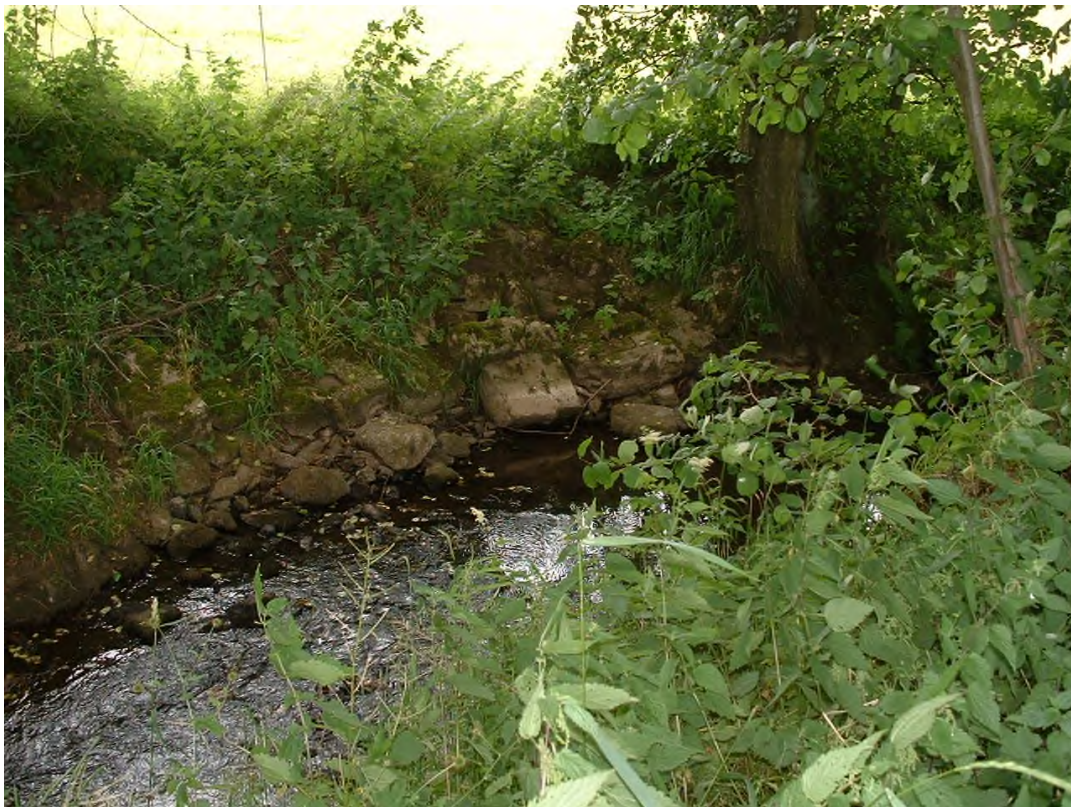
Abb. 8.2.2.1.1: Uferverbau im Steinaubach südlich von Hintersteinau verstärkt ....
