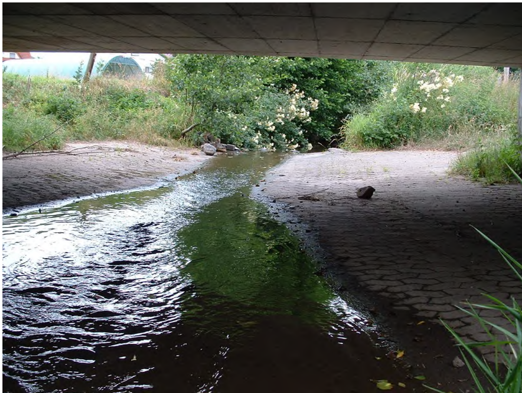
Abb. 8.2.3.1.2: Massivsohle im Brückenbereich bei Hintersteinau.
