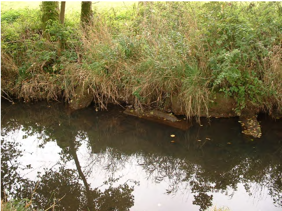
Abb. 8.2.3.2.3: massiv verbauter Steinaubach südlich von Hintersteinau.
