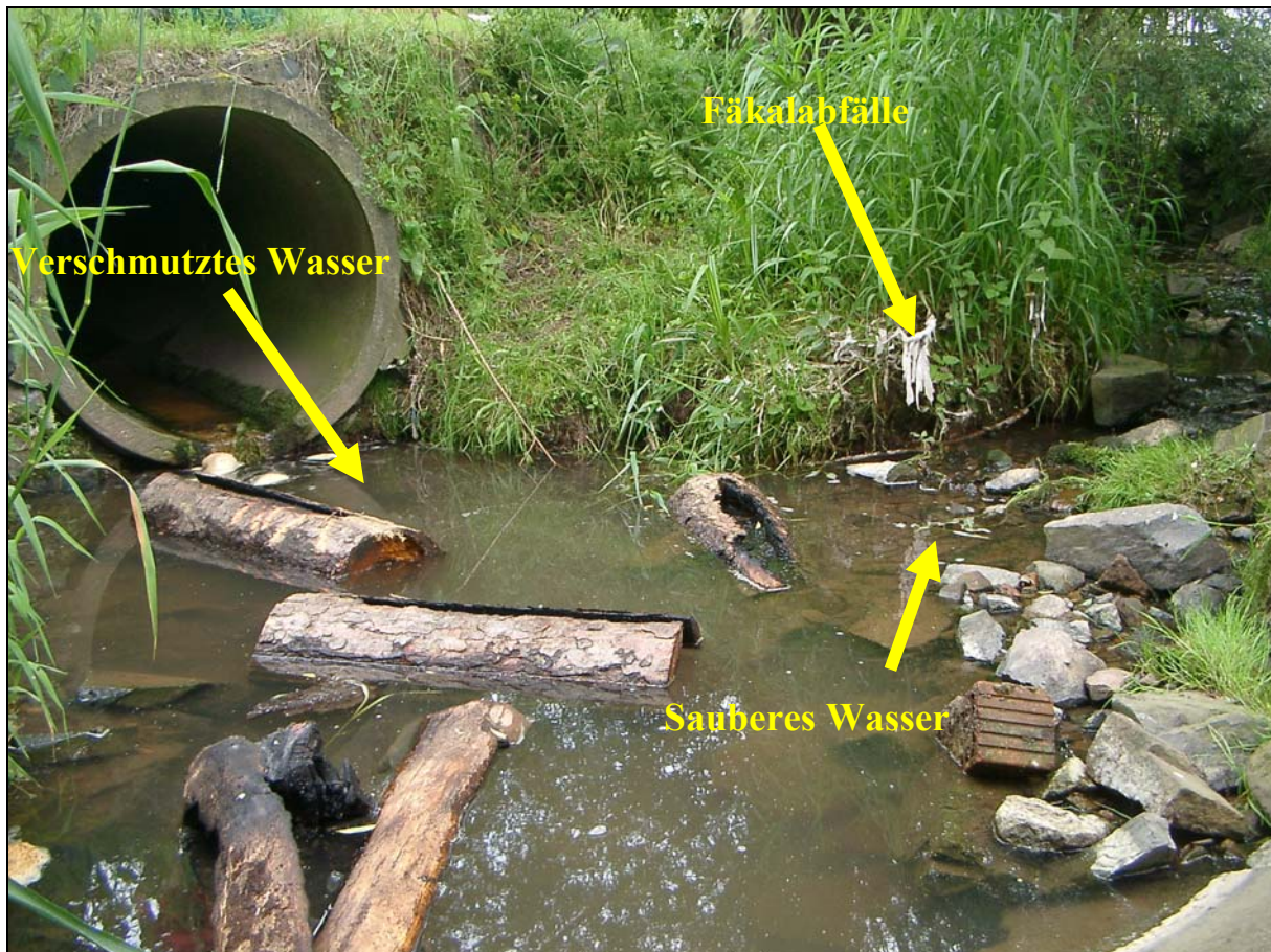
Abb. 4.4.1.2.4: Einleitungsstelle der Kläranlage Sterbfritz
