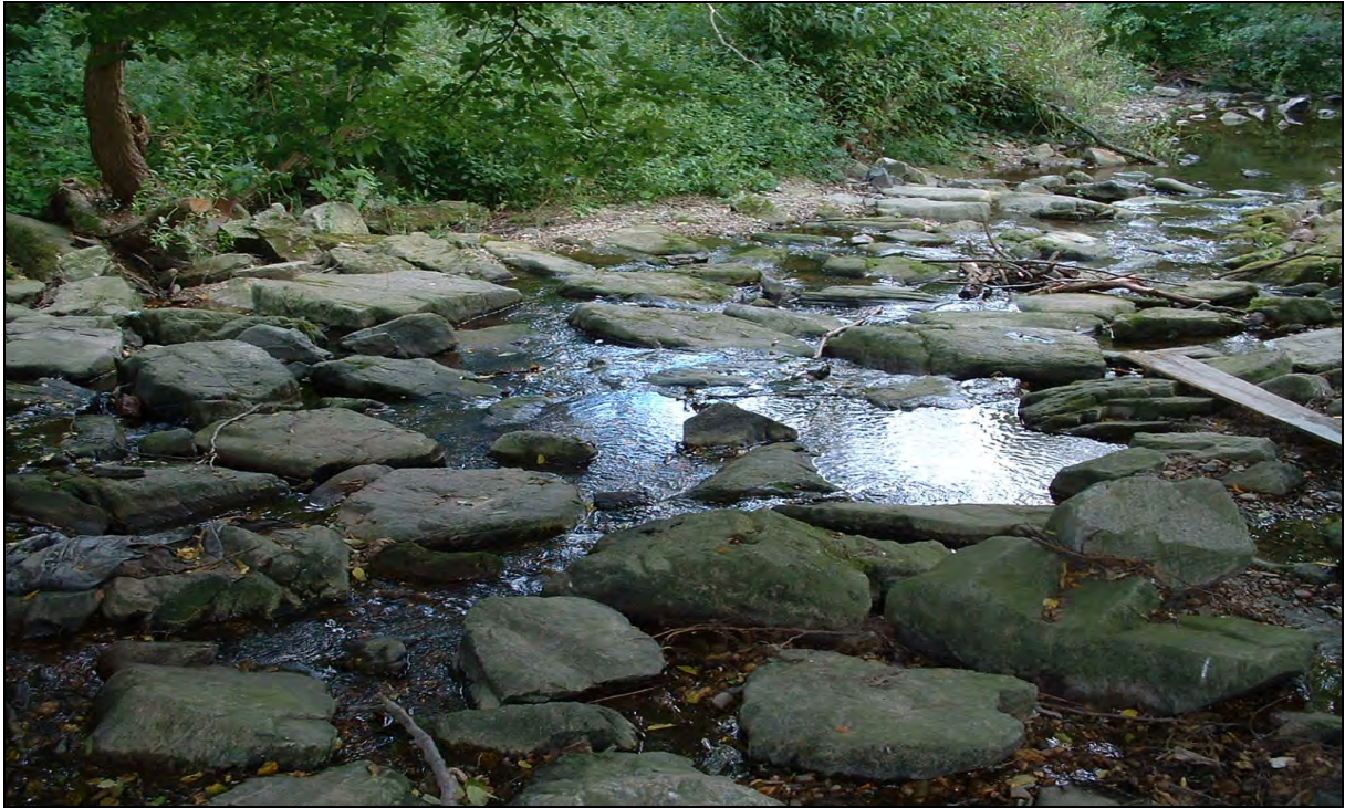
Abb. 8.2.1.1.3: Ein gelungenes Beispiel für eine passierbare Anrampung befindet sich in Burgholzhausen. Die ehemalige Ausleitungsstelle in einen Mühlgraben wurde durch grobe Blöcke naturähnlich umgestaltet.
