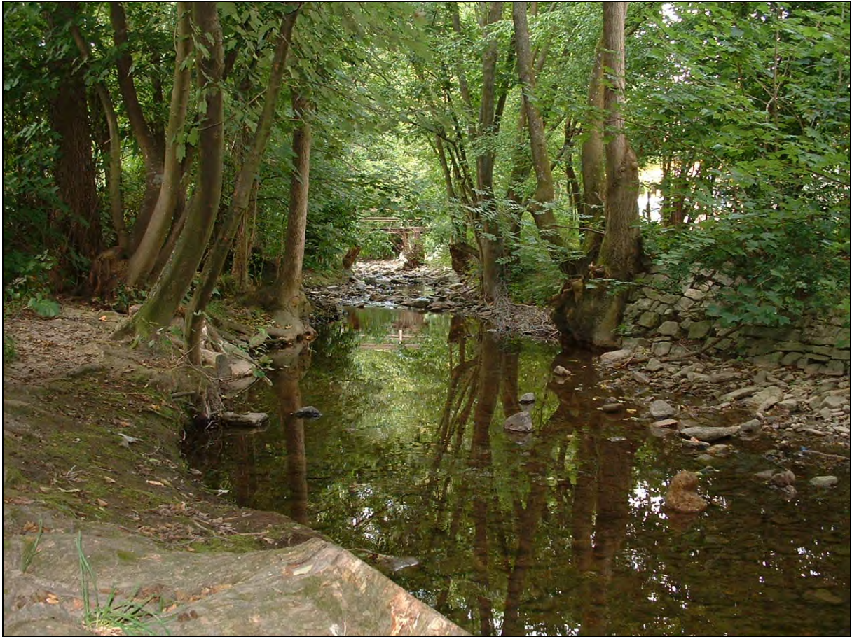
Abb. 8.2.4.2.1: Unverfugte Steinstückung im Uferbereich dient dem Erosionsschutz; sie beeinträchtigt die Lebensraumfunktionen nur marginal.
