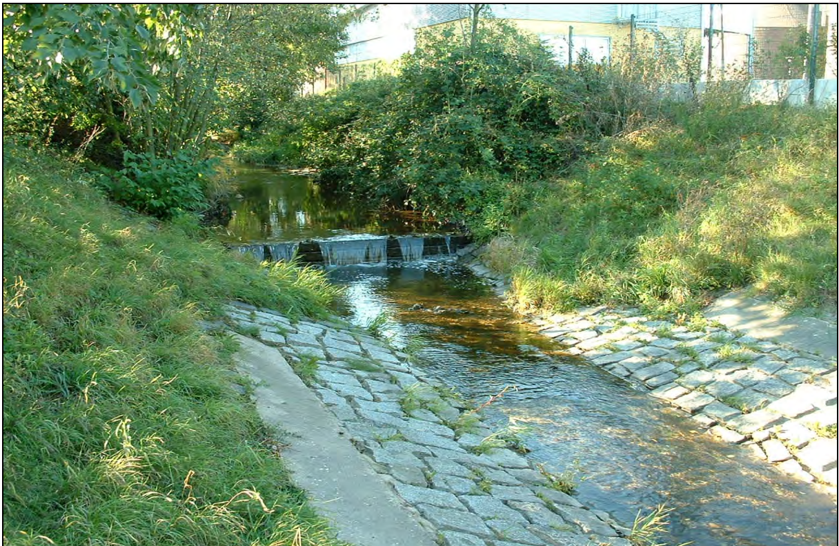
Abb. 8.2.1.1.2: Die Pegelmessstelle unterhalb von Ober-Erlenbach. Aufgrund der Funktion des Bauwerks gestalten sich notwendige Umbaumaßnahmen als schwierig.
