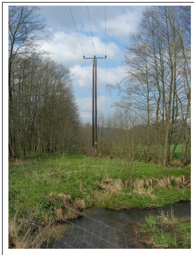
5577-401_Bild26_Gefährdung durch Freileitung am Klingbach.JPG
