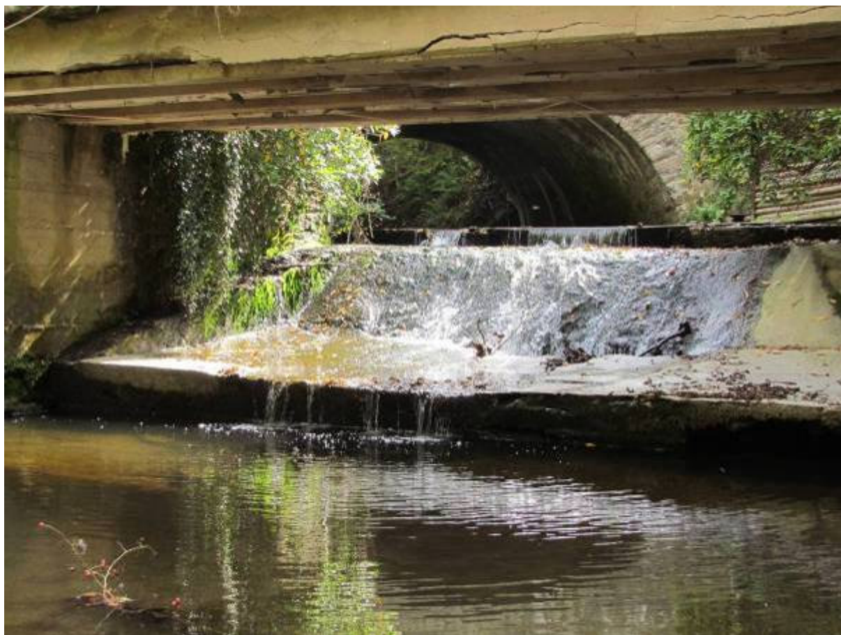
Abbildung 14: Wehr an der Lauksmühle
