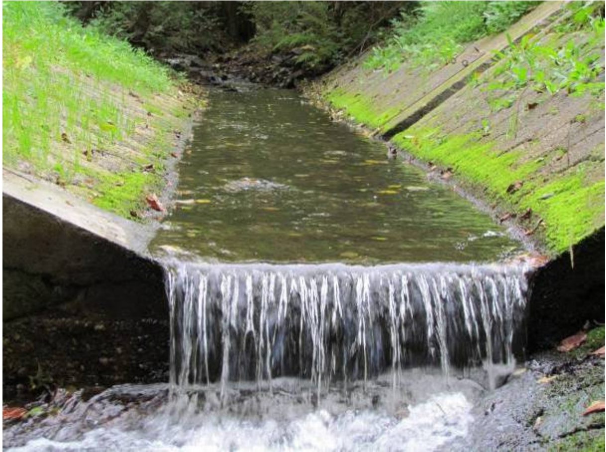
Abbildung 18: Sohlabsturz als Wanderungshindernis, Pegel an der Ernstbachmündung
