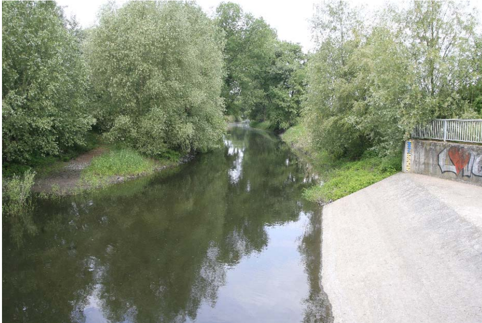
Foto 13: Der innerhalb des VSG liegende Teil des Schwarzbachs weist befestigte Uferbereiche auf (S.R. Sudmann, 28.05.2008).
