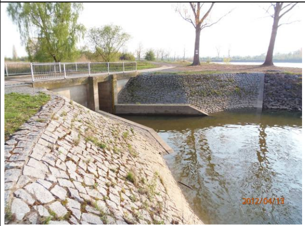
Abb. 30: Auslaufbauwerk Nordheimer Altrhein
