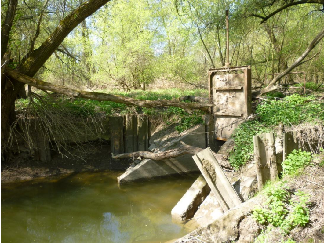
Bild 22: Ehem. Stauwehr für das Welsche Loch, inzwischen durch Bypass nicht mehr in Funktion.
