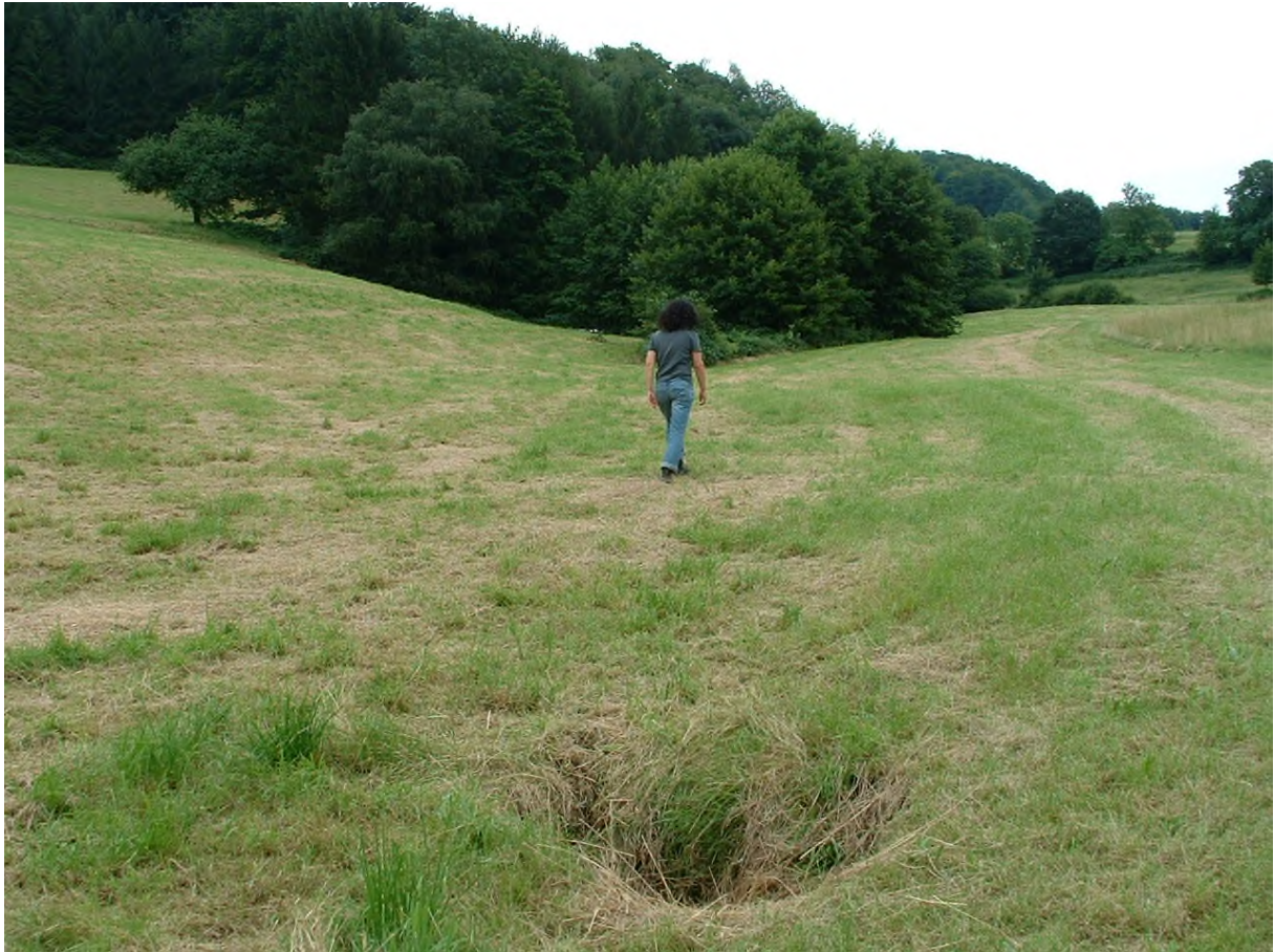
Abb. 8.2.2.3.1: Verrohrung in der freien Landschaft; der Bach ist vollkommen verschwunden. Als Maßnahme wird Offenlegung des Gewässers vorgeschlagen.
