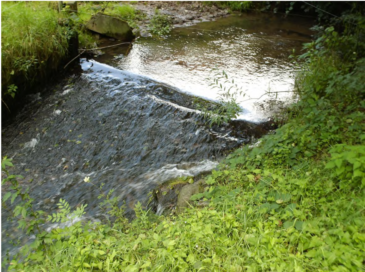
Abb. 8.2.1.1.3: Durch Umwandlung in eine raue Rampe werden Rückstaueffekte vermieden und gleichzeitig der Schutz vor Tiefenerosion gewährleistet.
