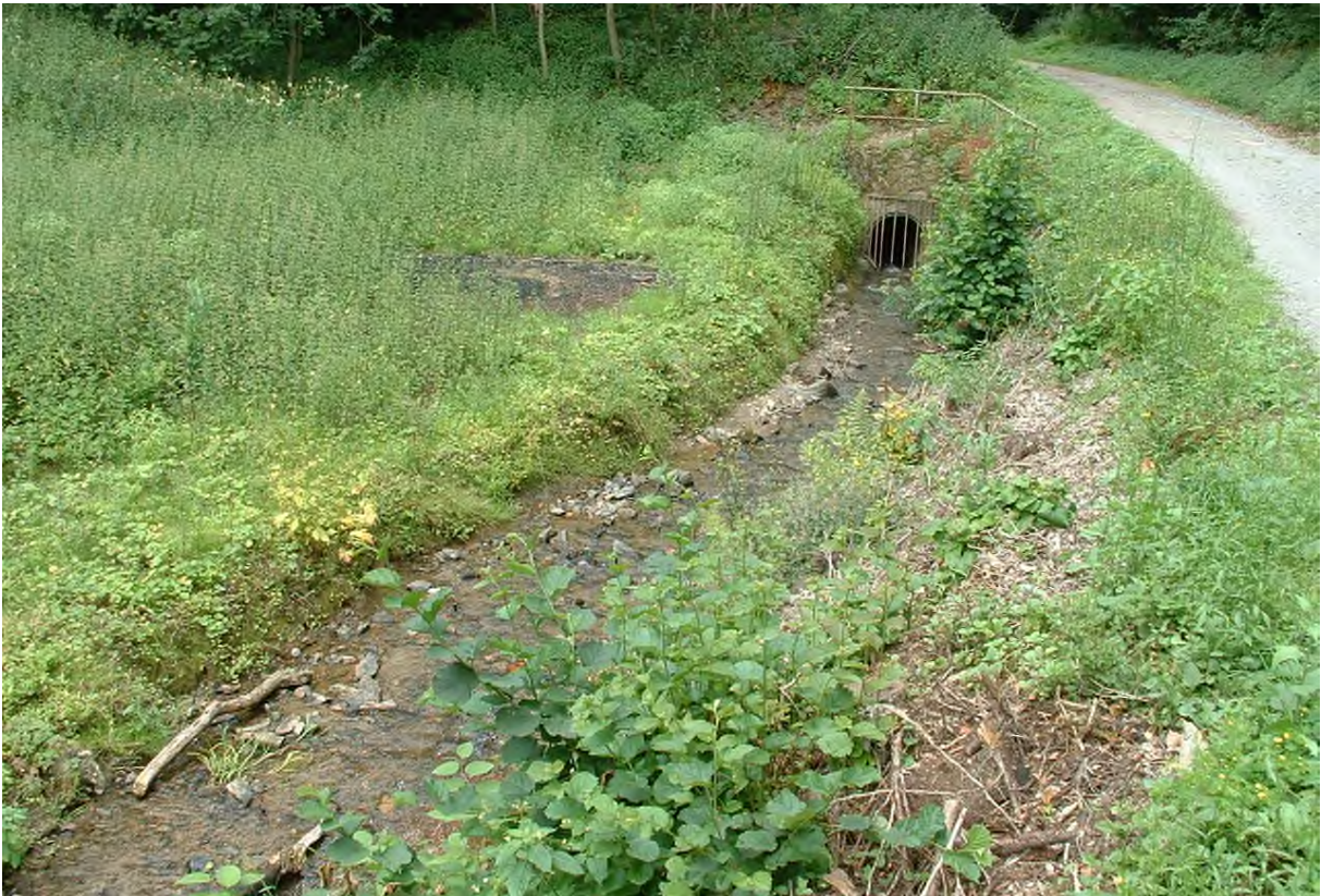
Abb. 8.2.2.3.3: Ab einer bestimmten Länge werden Verrohrungen infolge fehlenden Lichteinfalls nicht mehr durchwandert.
