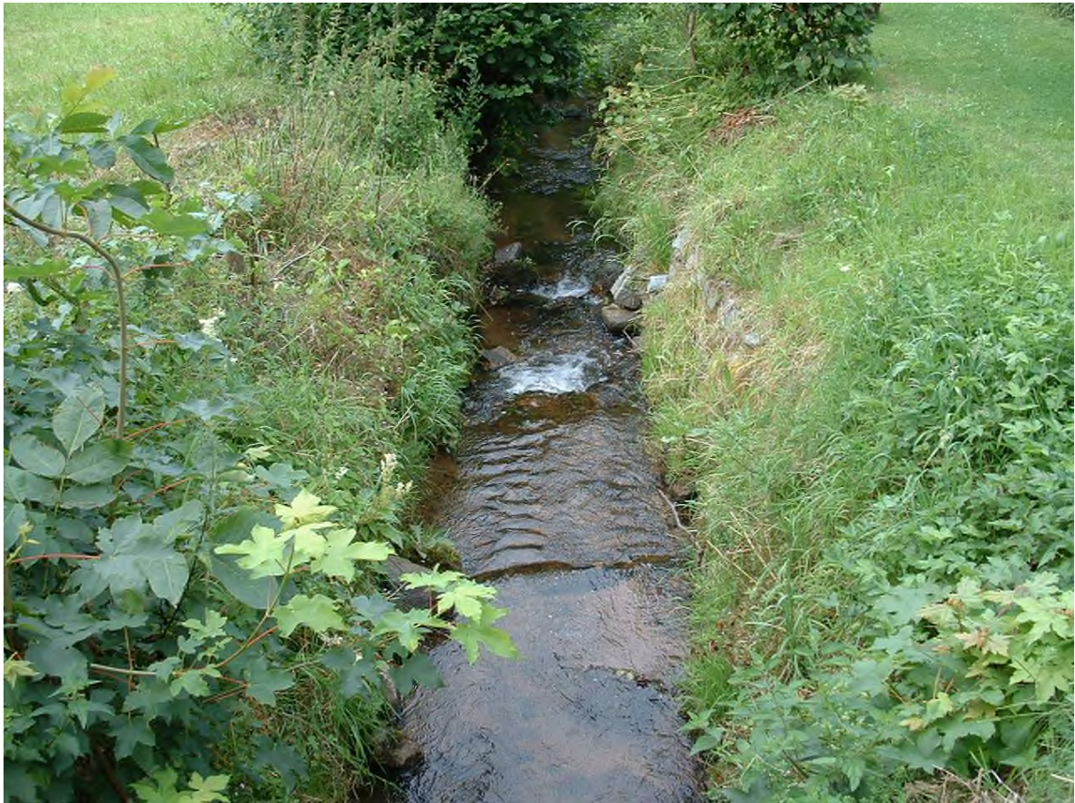
Abb. 8.2.3.3.1: Ausgebaute Altprofile mit Uferverbau ohne natürliche Breitenvarianz finden sich oftmals in Grünlandbereichen.
