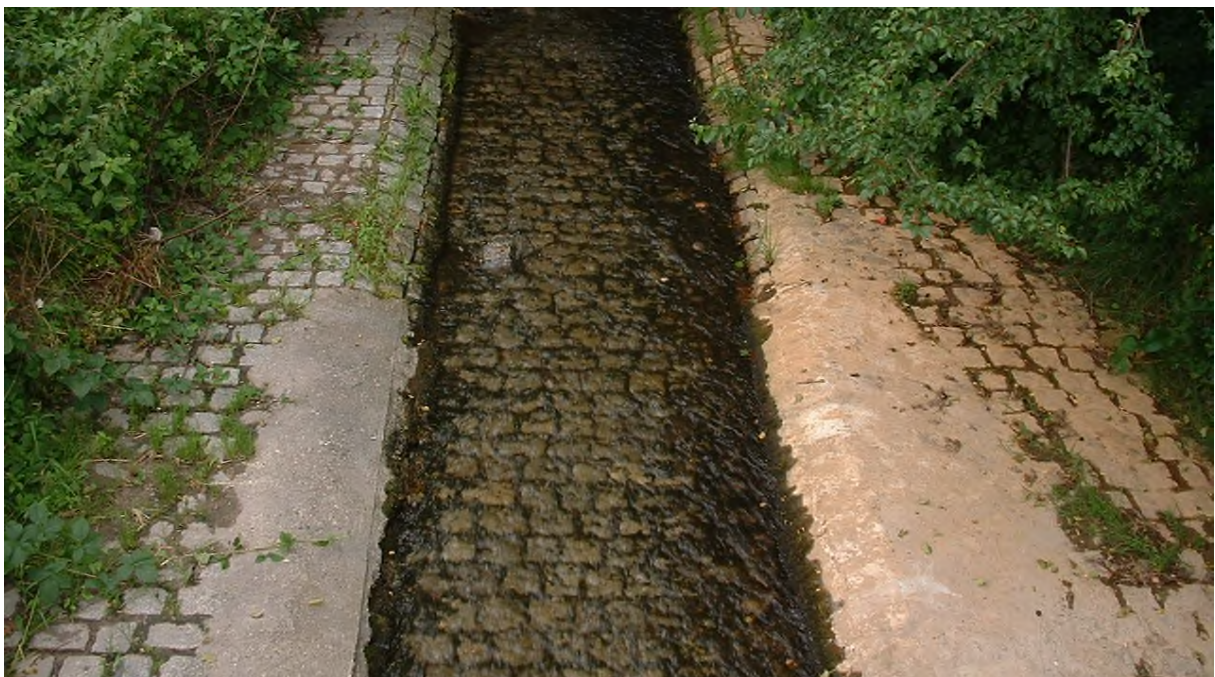
Abb. 8.2.3.1.1: Massivsohle ohne Besiedlungsmöglichkeit für Makroinvertebraten.
