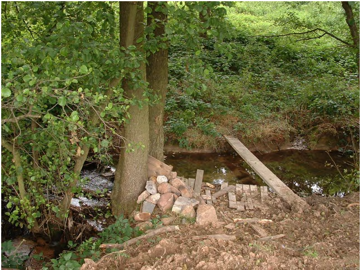
Abb. 8.2.1.1.1: Querverbau führt bei kleineren Gewässern zur Reduktion der Fließgeschwindigkeit und des Geschiebetriebes ...
