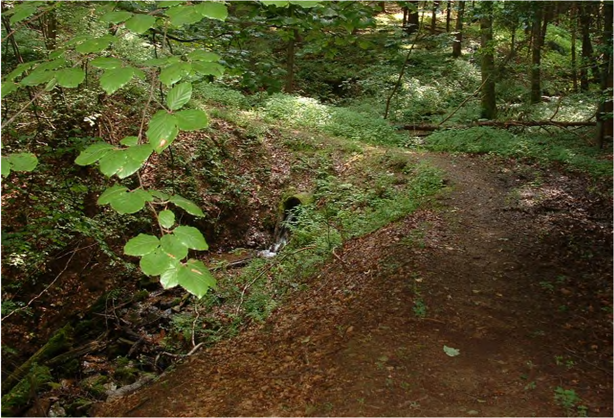
Abb. 8.2.2.3.2: Verrohrungen mit anschließendem Absturz; hier ist keine Passierbarkeit für die Fischfauna gegeben.
