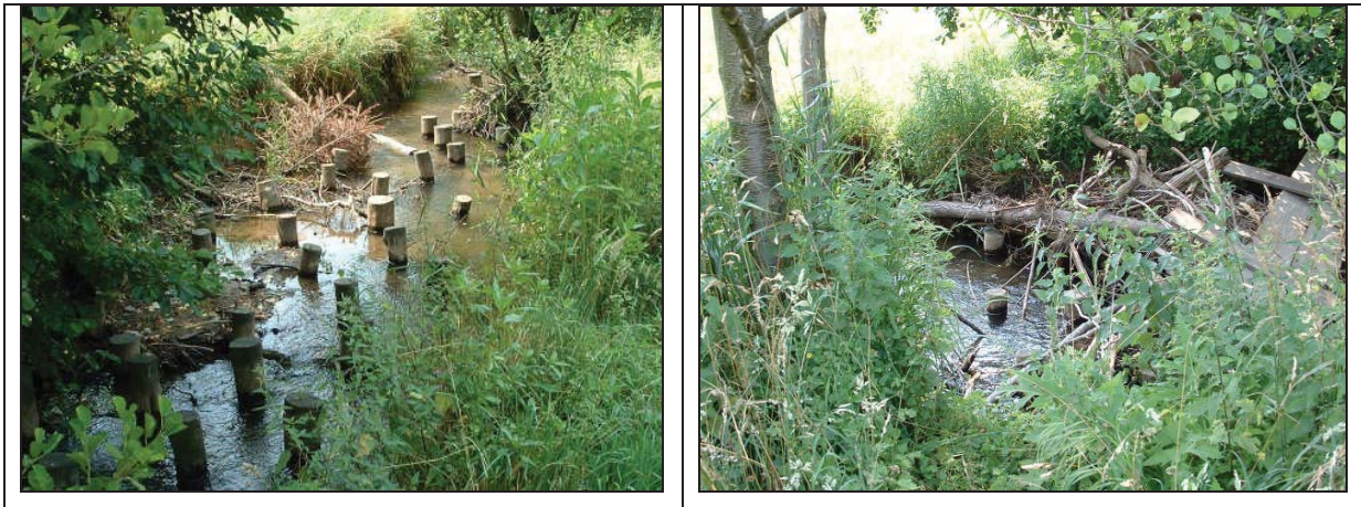
Abb. 8.2.3.1.1: Maßnahme gegen den Prozess der Tiefenerosion. Nur bei Entnahme des Totholzes kann die Rückstauwirkung und die hieraus resultierende übermäßige Sedimentierung feinkörniger, besiedlungsfeindlicher Substrate verhindert werden.
