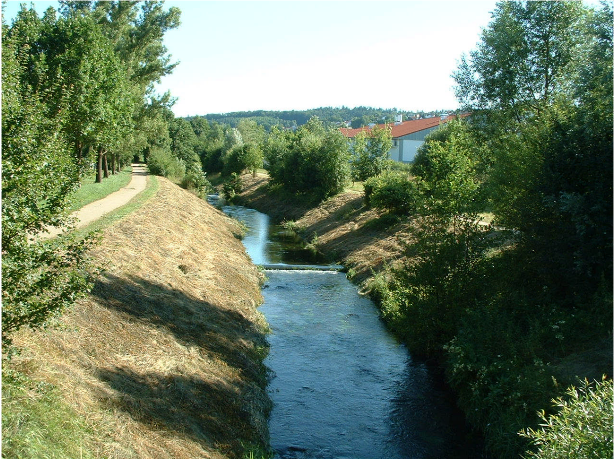
Abb. 8.2.2.1.1: Anforderungen des Hochwasserschutzes bestimmen das Trapezprofil im Bereich Erbach.
