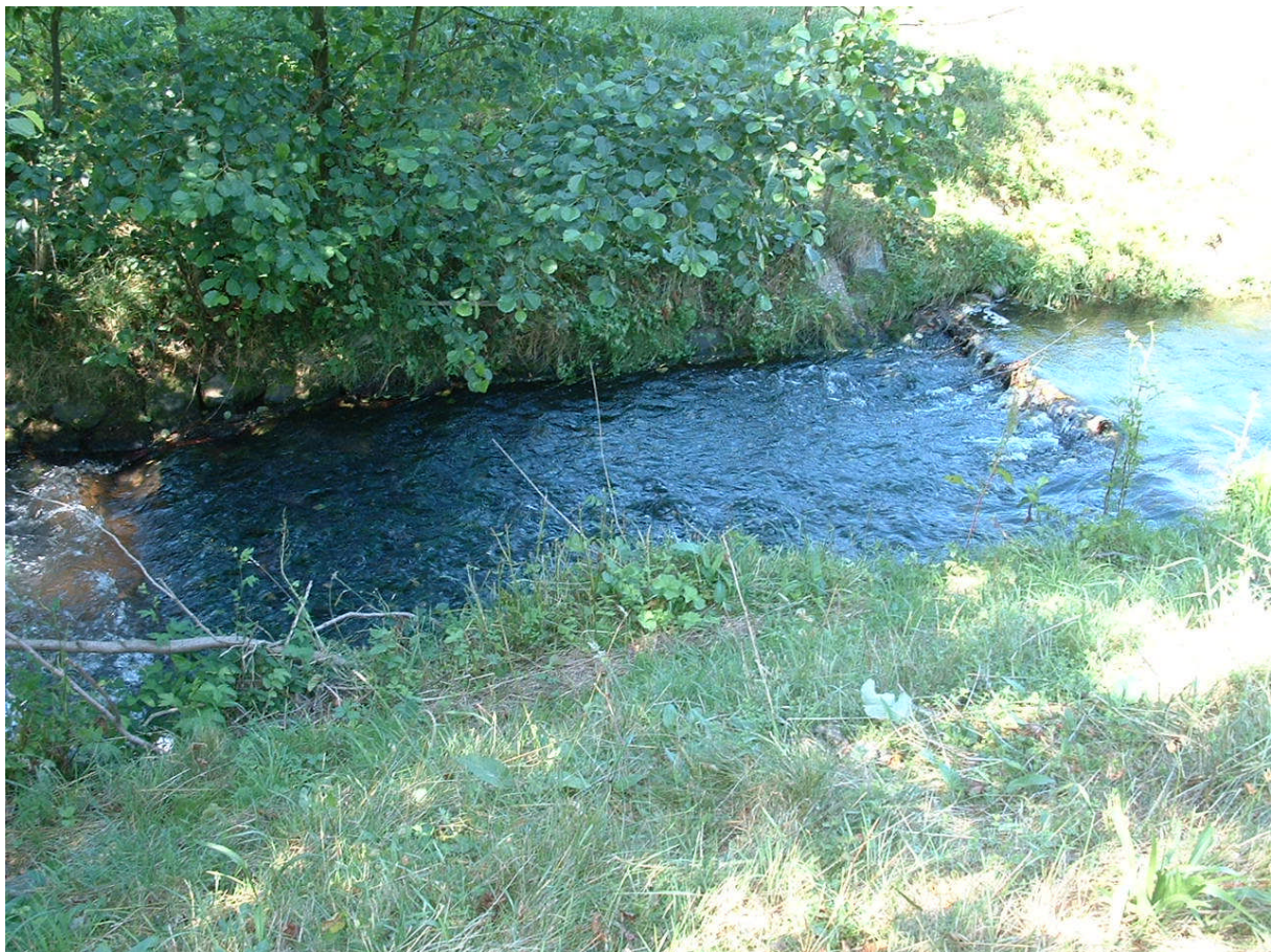
Abb. 8.2.4.2.1: Steinstickung im Bereich Marbach oberhalb des Hochwasserrückhaltebeckens vereinheitlicht die Gewässerstruktur.
