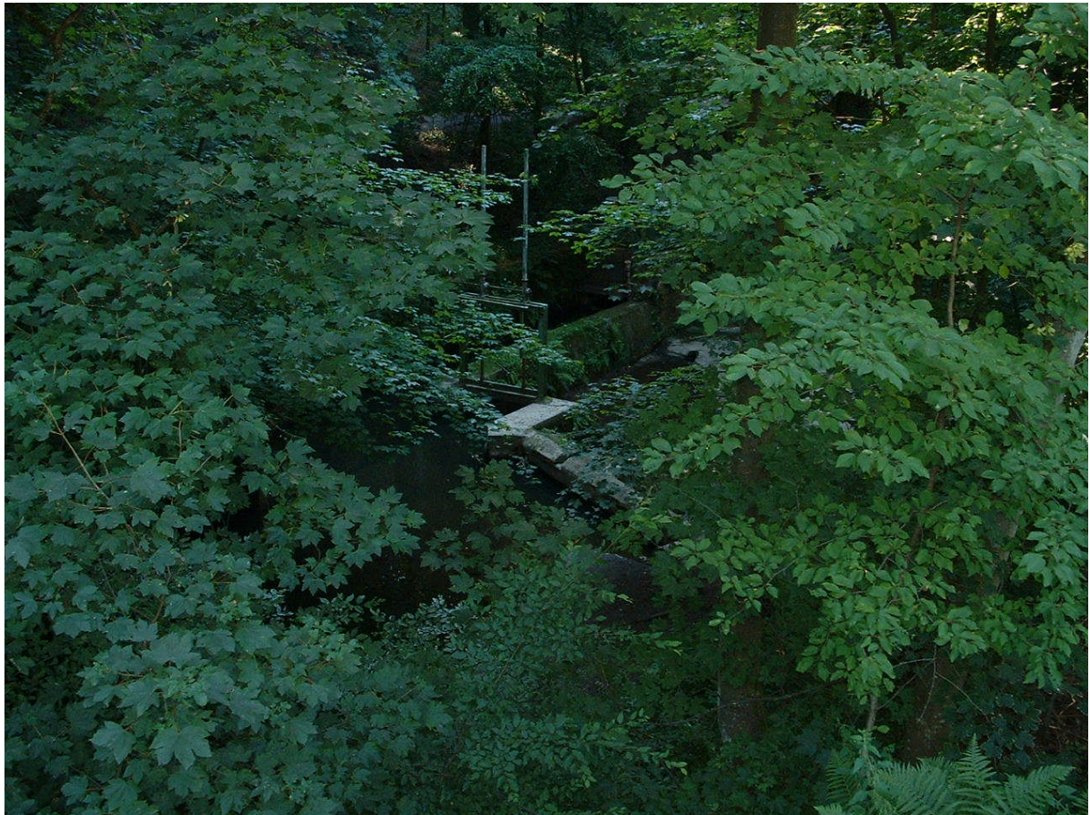
Abb. 8.2.1.1.2: ...stellen größere, aber lösbare Herausforderungen dar (QWB_2).
