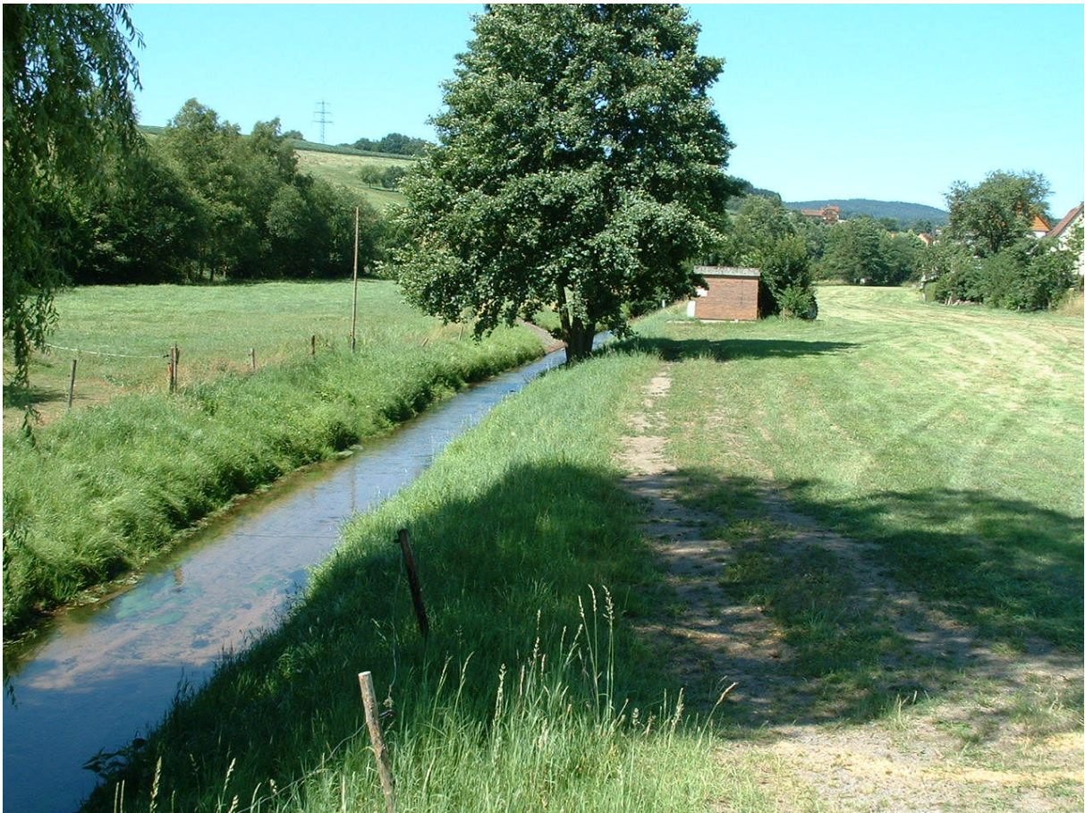
Abb. 7.1.2: Vollständiger Ausbau; natürlicherweise ist eine stark gekrümmte bis mäandrierende Laufentwicklung mit hoher Strömungsdiversität und Tiefenvarianz zu erwarten. Im Photo wird die stark eingeschränkte Substratvielfalt ersichtlich.
