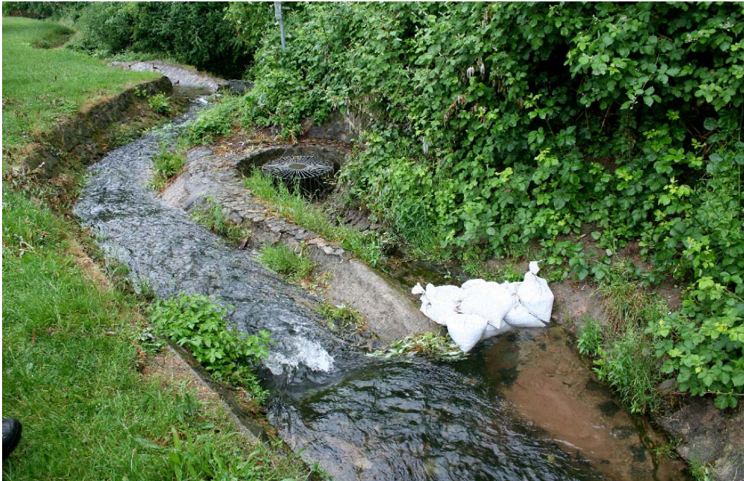
Der Eingang zum rechten Teil der Erdbachhöhle ist durch ein Schachtgitter zugänglich. Aufgrund der Wasserführung muss der Höhlenbach mit Sandsäcken umgeleitet werden. (Foto: S.Zaenker, 17.05.2007)
