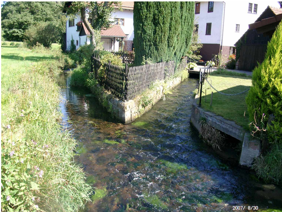
Foto 17: Uferverbau am Finkenbach, Gewässerabschnitt _63 – 30.08.2007
