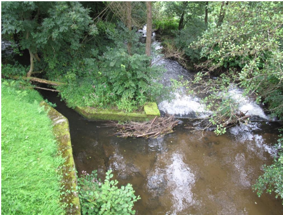
Abb.26 Wehr unterhalb Landstraße nach Heddesbach Foto: Wache
