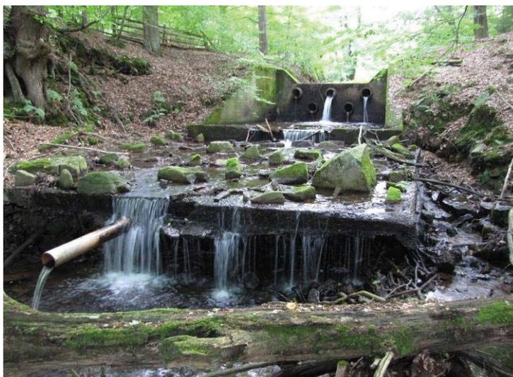
Für Fische nicht passierbar sind Sohlabstürze - z. B. unter Brücken (links) – Verrohrungen und Wehranlagen, die im Bereich der untersuchten Bäche zahlreich vorhanden sind. Aufnahmen beispielhaft am Hemelbach: 27.07.2010
