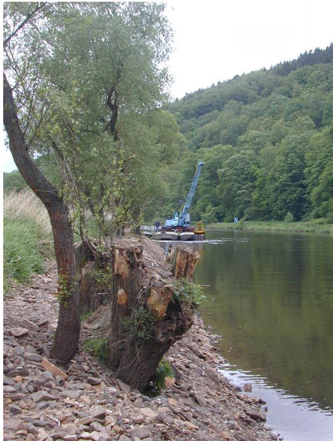
Abbildung 5: Eine im Rahmen der Fuldaunterhaltung mit Baggergut von der Flusssohle regelprofilierete Uferböschung.
