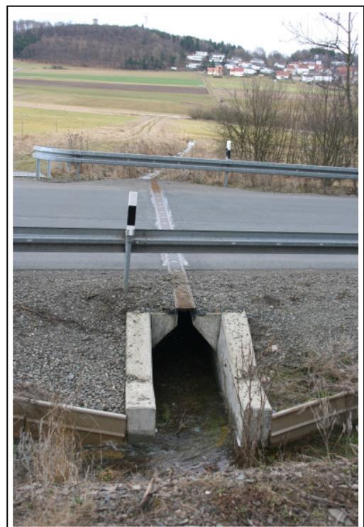
Abb. A-12: Durchlass mit stationärer Leitanlage für Amphibien an der L 3083
