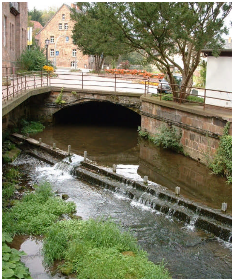
Abb. 6.2.1: Im Norden wird das FFH- Gebiet durch eine längere Verrohrung begrenzt.
