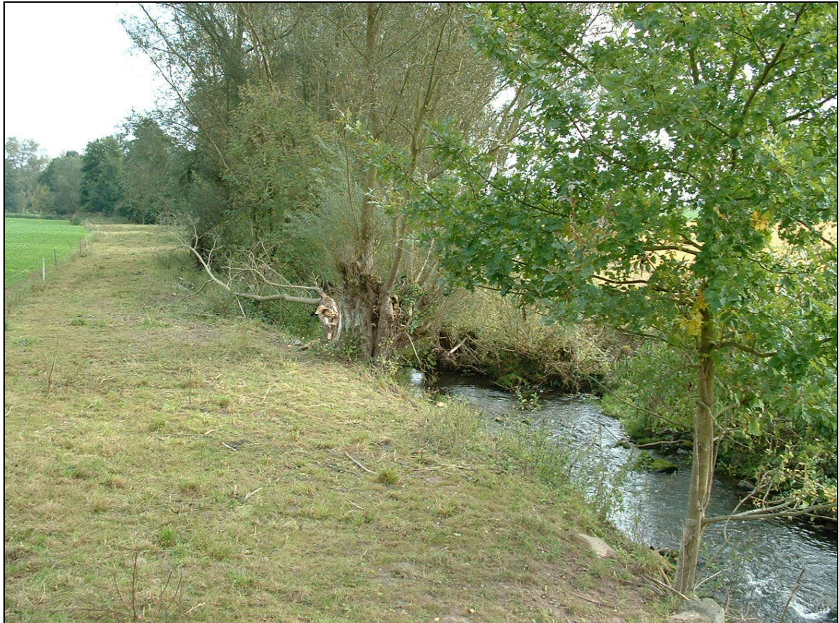
Abb. 8.2.1.1: Das Einbeziehen des Gewässerrandstreifens in die Nutzung und einreihige Ufergehölze in einem begradigten Gewässerabschnitt („Grünverrohrung“) verhindern eine eigendynamische Entwicklung. Im lückigen Gehölbereich könnte durch Verlagerung des Strömungsstrichs (Totholz) infolge Lateralerosion Initiale der Gewässerentwicklung gesetzt werden.
