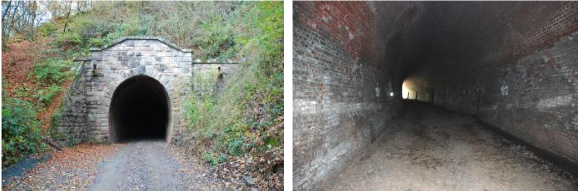
Abb. 1: Tunnelöffnung aus Richtung Reddighausen (links) und Innenansicht des Tunnels Dodenau.
