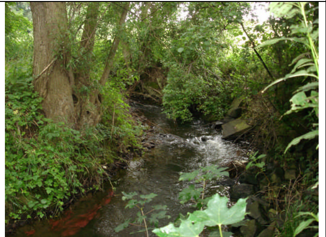
Uferverbau oberhalb Niederurff
