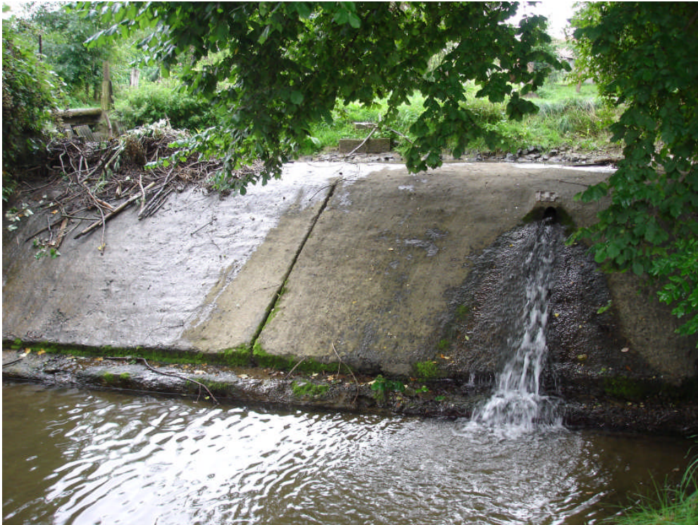
Abb. 4.1.3.4.1: Sehr geringe „Restwassermenge“ in der Ausleitungsstrecke der „Niedermühle“ in Niederurff
