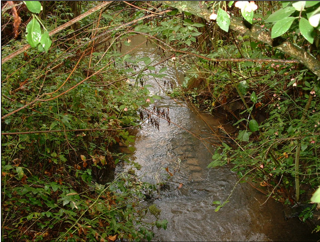
Abbildung 8.2.3.1.1: Sohlenverbau findet sich insbesondere hinter Verrohrungen.
