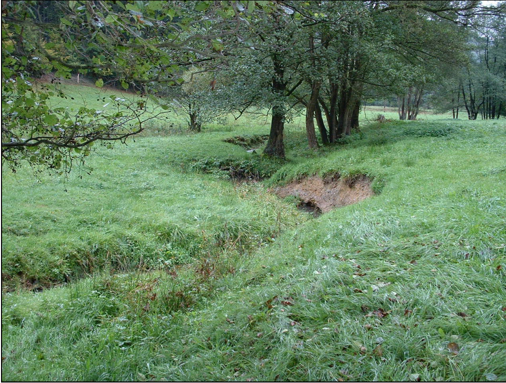
Abbildung 8.2.4.1.2: ... eigendynamische Entwicklungsansätze; sporadische Hochwasserabflüsse erklären den Formungsprozess, zum Teil werden die Erosionsvorgänge durch die abflussbündelnden Verrohrungen verstärkt.
