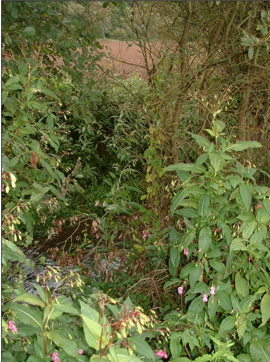
Abbildung 8.2.2.1.1: Der Gewässerverbau zwischen Niederurff und Einmündung in die Schwalm fördert Tiefenerosionsprozesse.
