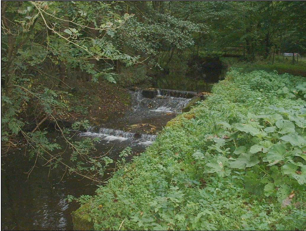
Abbildung 8.2.1.1.3: Der „doppelte Absturz mit Teilrampe“ (QWB_12) dient der Wasserausleitung für die Teichanlagen zwischen Bergfreiheit und Oberurff-Schiffelborn. Die Varianten Fischpass/Anrampung/Umgehungsgerinne müssen diskutiert werden.
