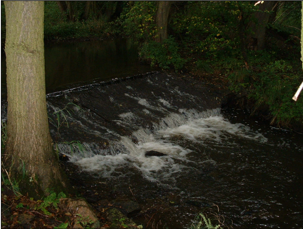
Abbildung 8.2.1.1.5: Streichwehr (QWB_15) oberhalb Oberurff-Schiffelborn.
