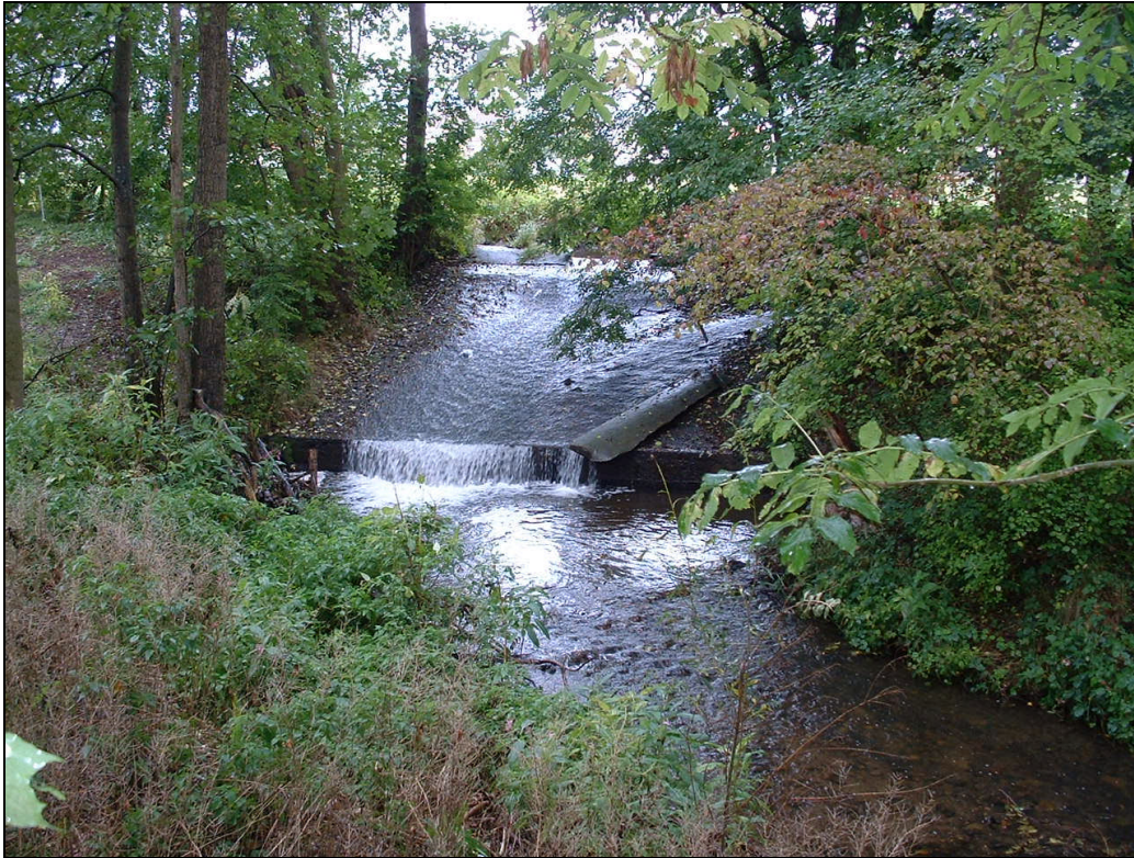
Abbildung 8.2.1.1.7: Größere Herausforderungen stellen die Wehre „Obermühle“ (QWB_19)...
