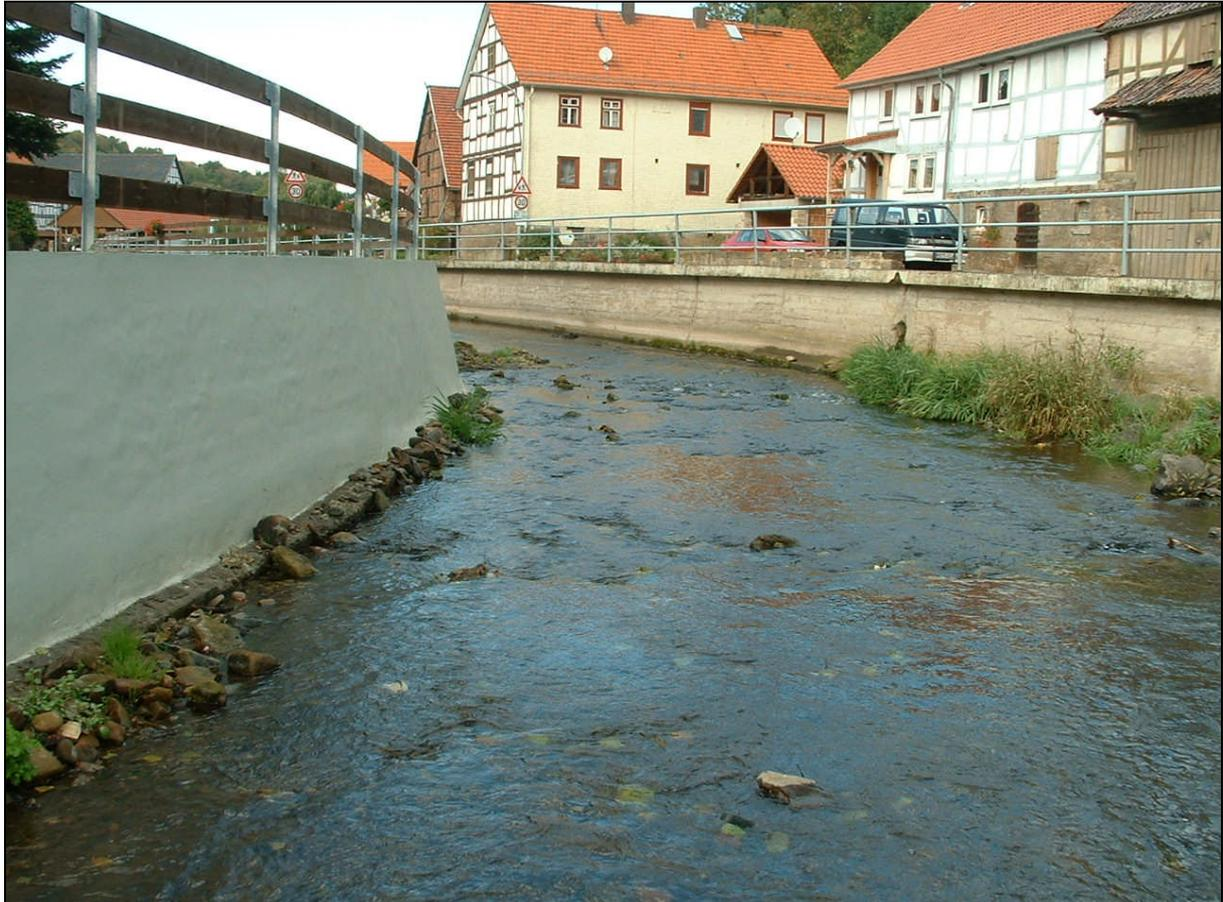
Abb. 8.2.3.1.1: Hochwassersicherung durch Sohl- und Uferverbau in Remsfeld.
