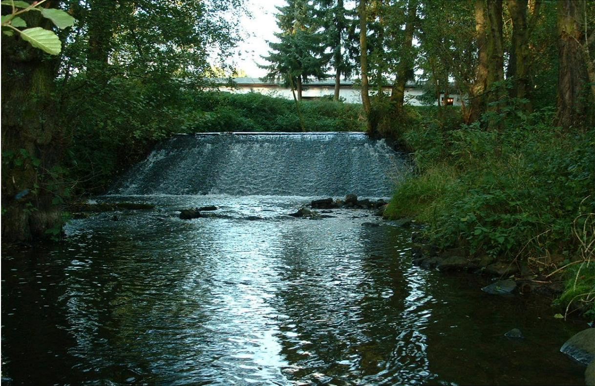
**Abb. 8.2.1.1.7:** QWB\_23. Zur Wiederherstellung der Durchgängigkeit ist ein Umgehungsgerinne geplant (UNGER 2006); die Genehmigung ist erteilt.
