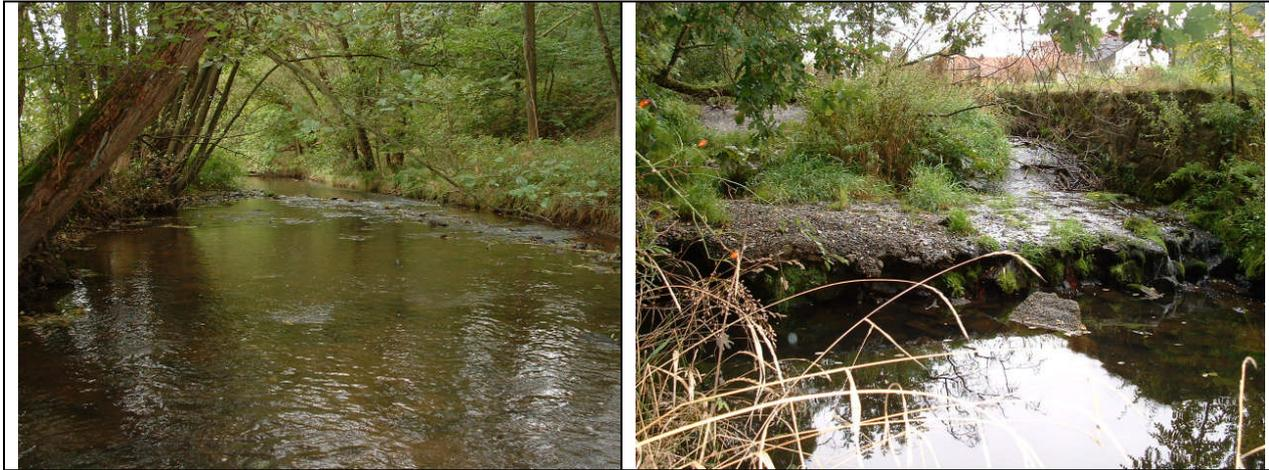
**Abb. 8.2.1.1.2:** QWB\_2 – das rechte Bild dokumentiert die Ausleitung in einen Mühlgraben im nördlichen Siedlungsbereich von Völkershains; deutlich wird das Problem der übermäßigen Wasserentnahme. Das linke Bild zeigt die Efze 50 Meter oberhalb des Querbauwerks.
