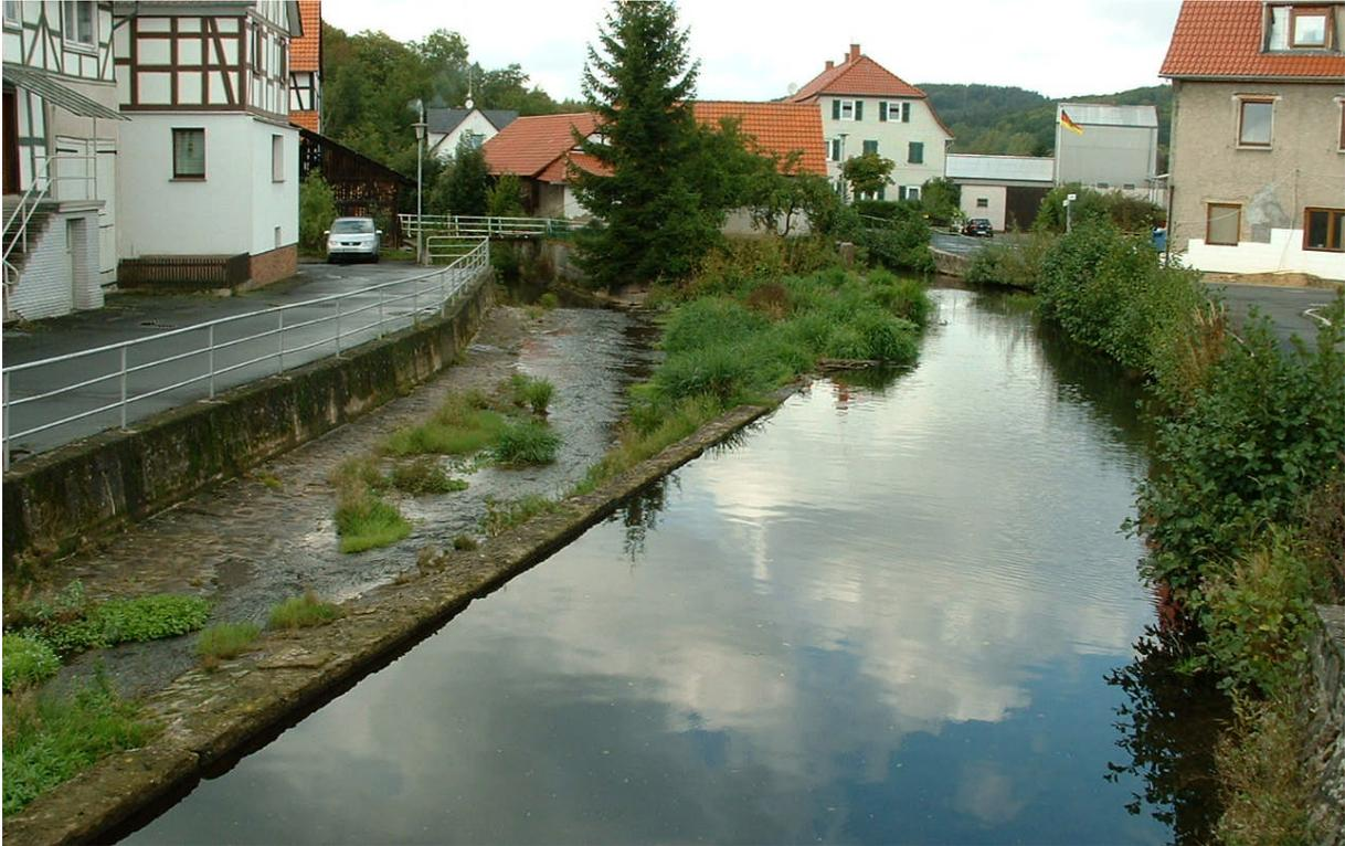
**Abb. 8.2.1.1.5:** QWB\_20. Massiver Ausbau (links Efze, rechts Mühlgraben). Der Umbau wird in der Genehmigungsplanung zur Efze-Renaturierung erläutert (UNGER 2006). Die Effizienz der Maßnahme ist vor allem von der Mindestwasserführung abhängig.
