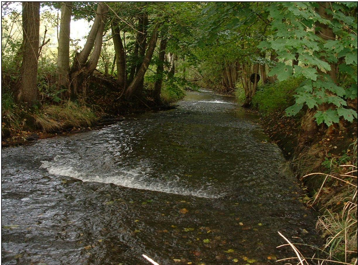
Abb. 8.2.3.2.1: gestaffelt angelegte „Sohlschwellen“ und Verbaumaßnahmen der Sohle fixieren den Verlauf der Efze nahe der L3153 südlich von Reddinghausen.
