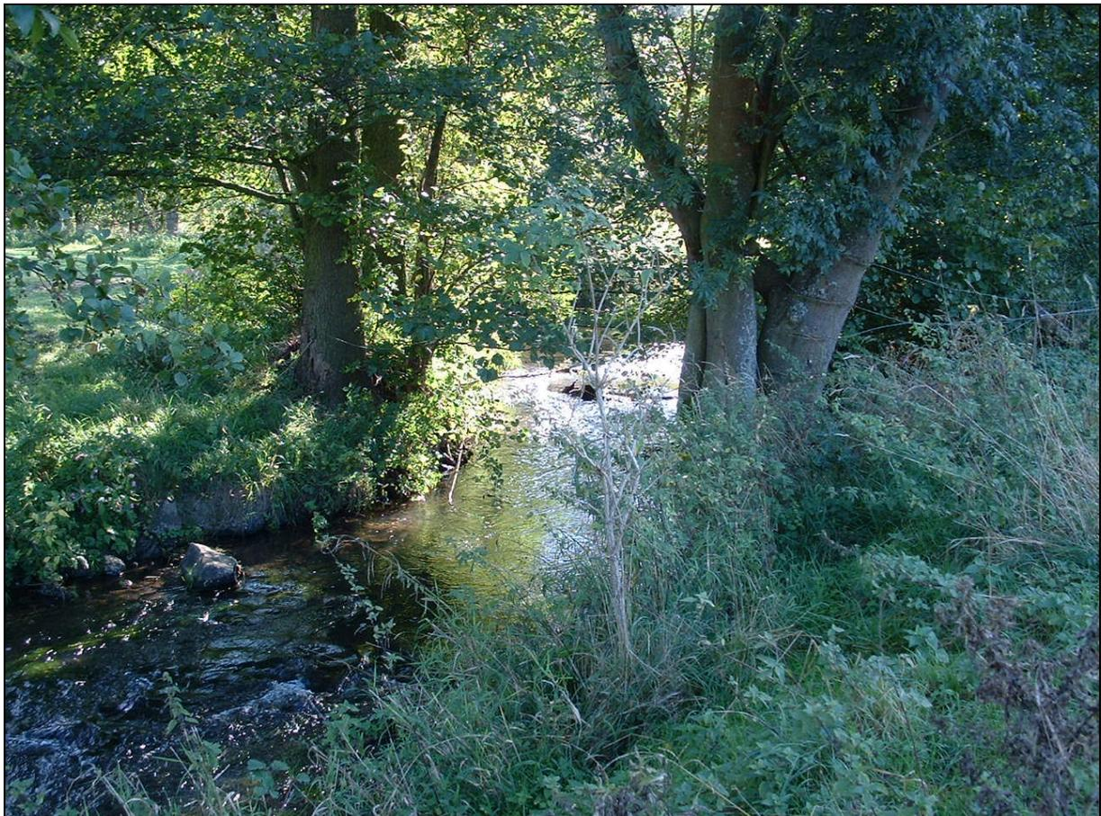
Abb. 8.2.4.2.1: Auf den ersten Blick naturangenehmer wirkt man erkennt dennoch deutlich den Uferverbau durch Steinstückung.
