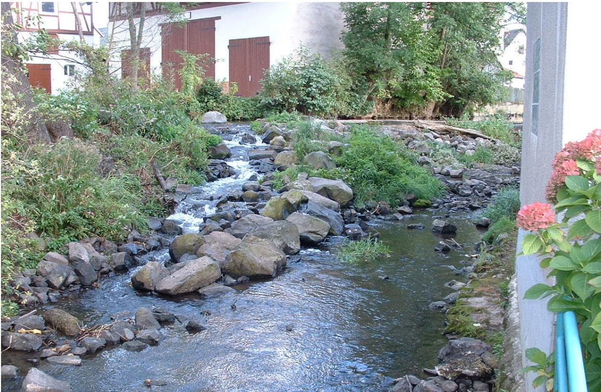
**Abb. 8.2.1.1.8:** Bereich Holzhausen - das Querbauwerk QWB\_26 ist nicht für alle Altersklassen der Bachforelle passierbar; für die Groppe fehlen strömungsberuhigte kleinere Becken, die Fischtrappe ist für die Art insgesamt zu steil.
