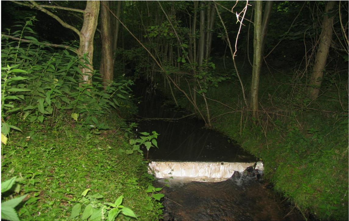
Abb. 2: Querbauwerk im Stärkelsbach mit dichten Erlenbeständen als Befestigung der Uferböschung
