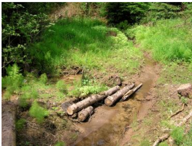
Abb. 9: Bereich des Abschlags im Untersuchungsjahr: Augenscheinlich sollte das Bachwasser mit Hilfe der provisorischen Holzbarriere geradeaus in den Umgehungsgraben geleitet werden, tatsächlich floss es jedoch nach links ab und damit über Teich 4 durch die gesamte Teichanlage. (Foto: Dirk Leifeld)
