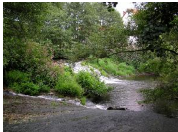
Abb. 14: Das Streichwehr der nicht mehr betriebenen Wiesenmühle (Lüder) in Ober-Bimbach sollte möglichst weitgehend zurückgebaut („geschliffen“) werden, um mehr Fließstrecke zu gewinnen. (Foto: Dirk Leifeld)
