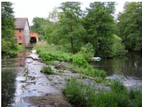
Abb. 13: Das Streichwehr der Windseßmühle (Lüder) in Uffhausen ist ein Wanderungshinderniss, obwohl alle räumlichen Möglichkeiten zur Anlage eines qualifizierten Umgehungsgerinnes gegeben sind. (Foto: Dirk Leifeld)
