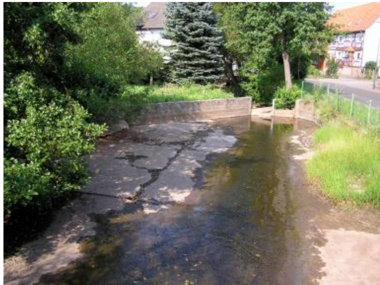
Abb. 16: Mehrere solche nicht durchgängigen Bachstau (hier in Schletzenhausen) sind im Verlauf der Jossa angelegt worden – sie dienen vermutlich im Bedarfsfall als Feuerlöschteich. (Foto: Dirk Leifeld)
