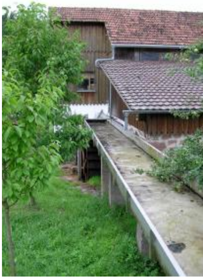
Abb. 15: An der Zwickmühle wird das gesamte Wasser der Kalten Lüder über das Wasserrad geleitet. (Foto: Dirk Leifeld)
