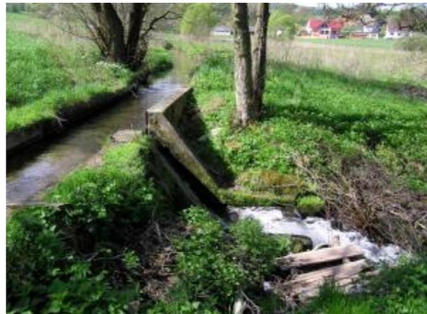
Abb. 20: Das unpassierbare Streichwehr der Döngesmühle (keine Wasserkraftnutzung) isoliert den Oberlauf des Magdloser Wassers vollständig vom Unterlauf mit seinen Groppen und Bachneunaugen-Vorkommen. (Foto: Dirk Leifeld)
