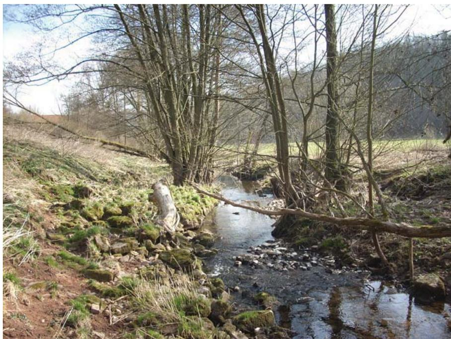
Abbildung 11: Überreste der Böschungssicherung des im Verfall begriffenen Regelprofils und einer Ufermauer aus Sandstein.
