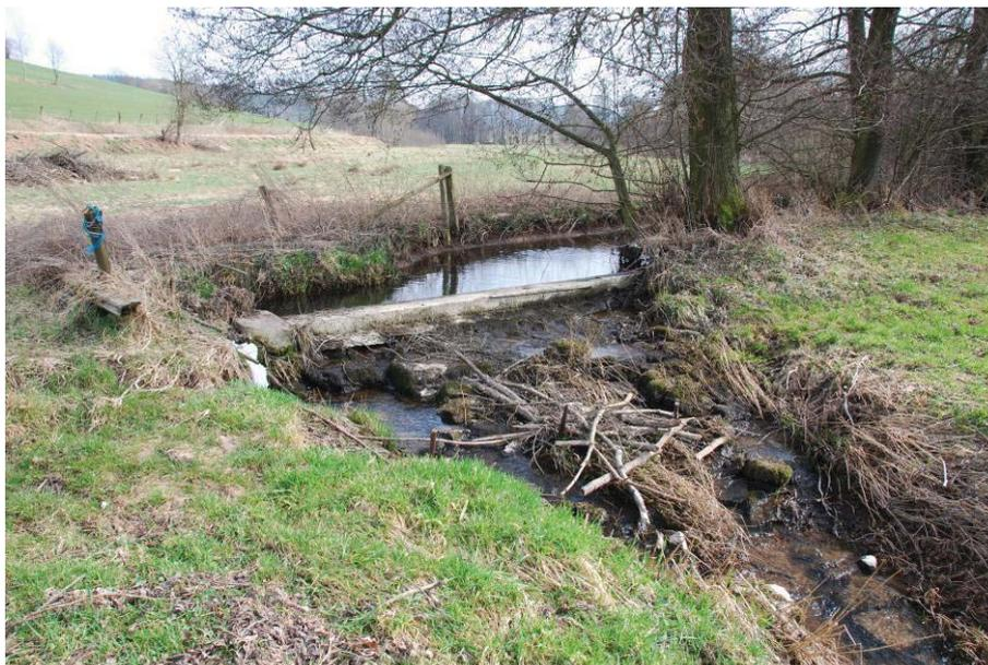
Abbildung 9: Marodes Ausleitungsbauwerk bei km 18+480
