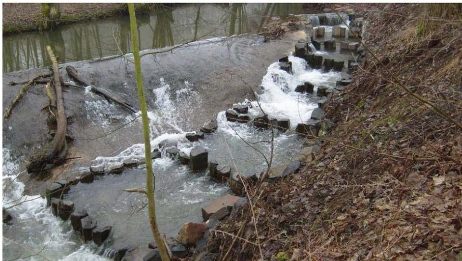
Abbildung 4: FAA mit verlegter Einlaufscharte bei Nüst Station km 3+110
