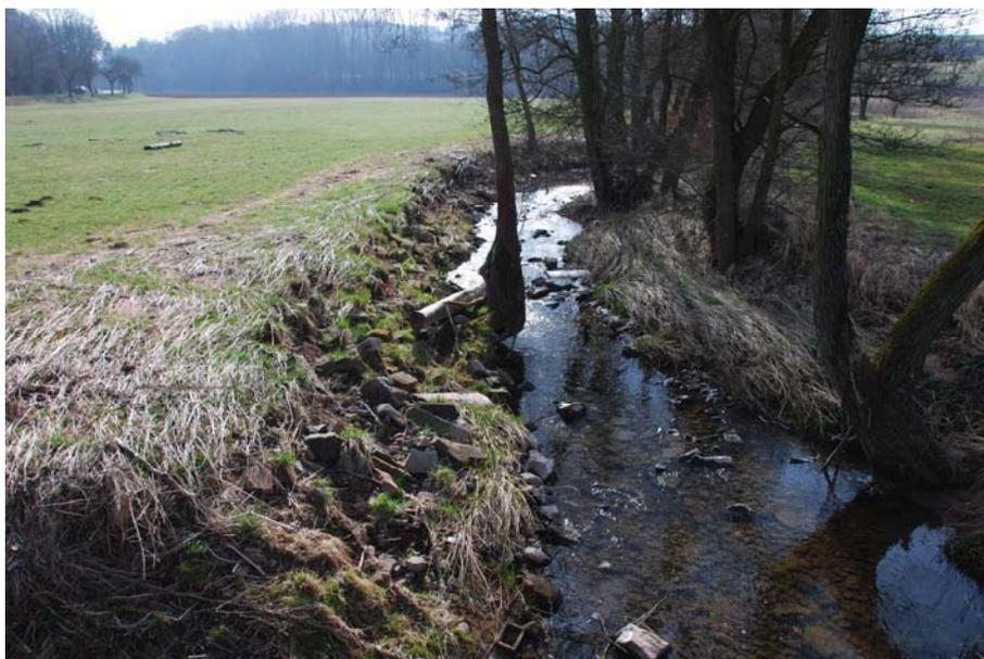
Abbildung 17: Bereits stark erodierte Ufersicherung bei Mackenzell. Verhältnismäßig zur Förderung der eigendynamischen Entwicklung ist hier eine Entnahme lokal verbliebener Reste der Ufersicherung.
