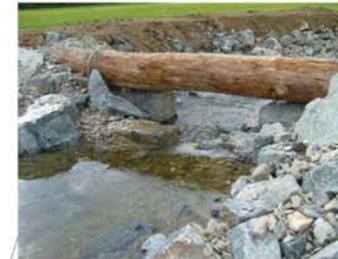
Abb. 4: Beispiel einer Einlaufbegrenzung mit querliegendem Stamm an einer Wanderhilfe am Liebrighäuser Wehr (Eder).
