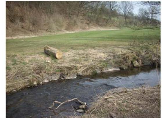
Abb. 1: Die Ufer der Nüst sind über weite Strecken mit einer Schüttung aus Blocksteinen gesichert (z.B. Nüst Stat. km 14+500)
