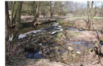
Abb. 2: Bei niedrigem Abfluss zeigt sich der schlechte bauliche Zustand der Wehranlage.
