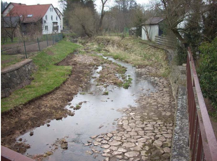
Abbildung 4: Gepflasterter Sohlenbereich des Brandbachs in Wickerts
