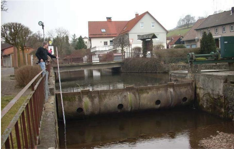
Abbildung 9: Unpassierbares Wehr bei Station km 2+200 am Brandbach in Wickerts
