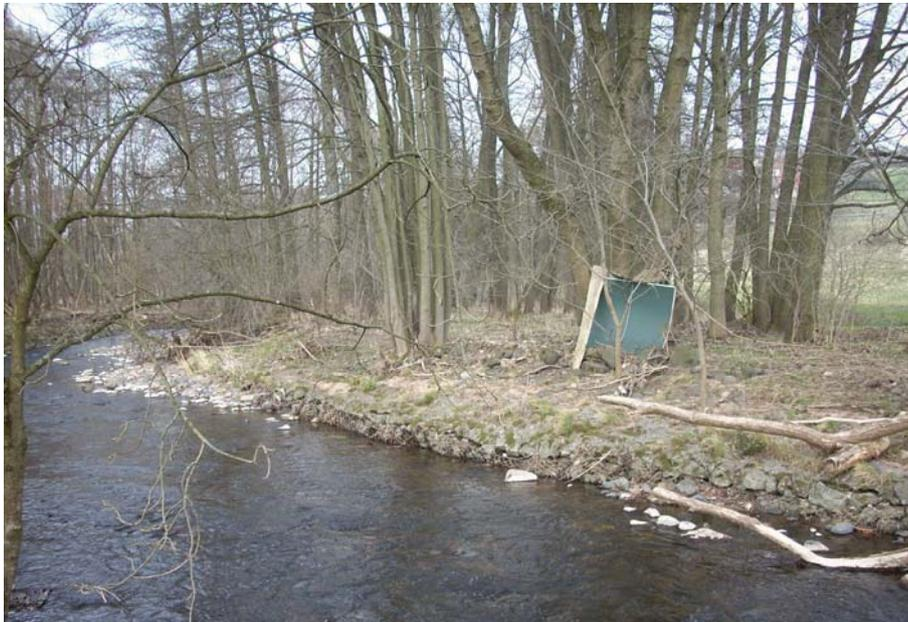
Abbildung 17: Unfachgemäß gesicherte Ufer der Ulster zwischen Station km 44+000 und km 44+050
