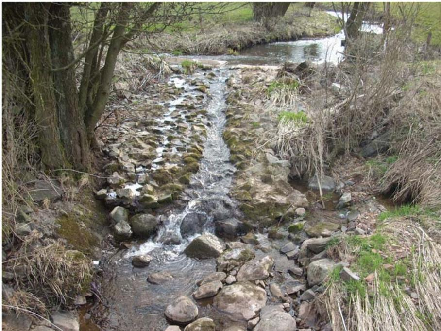
Abbildung 6: Betonierte Rampe mit Stauvorrichtung im Brandbach bei Station km 5+000
