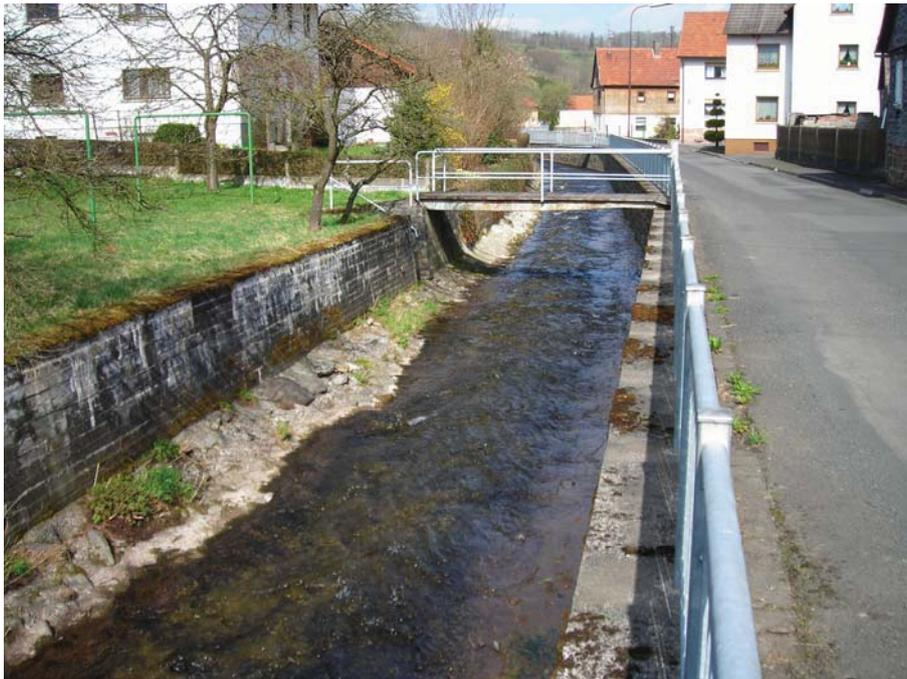
Abbildung 5: Ausgebauter Gewässerabschnitt der Ulster in der Ortslage von Seiferts mit betonierter Sohle
