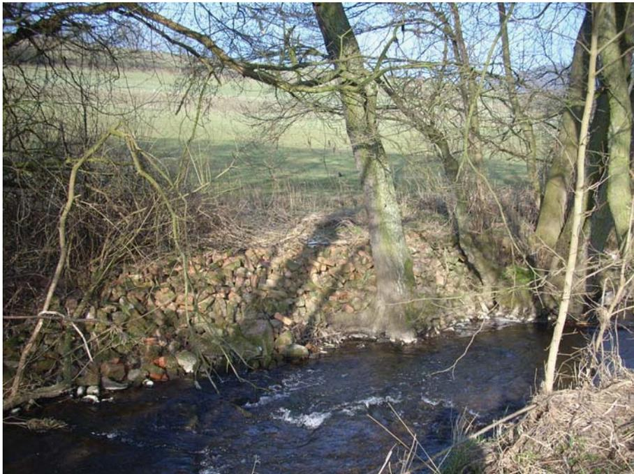
Abbildung 13: Uferverbau aus Bauschutt am linksseitigen Ufer der Weid bei Station km 1+450.
