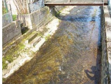
Abb. 2: Istzustand; Detail der massiven Sohle; durch die glatte Oberfläche und die relativ hohen Fließgeschwindigkeiten ist dieser Ulster-Abschnitt für schwimmschwache Wasserorganismen nur schwer zu passieren
