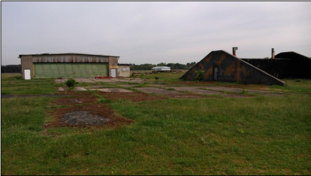
Foto 5: Alte Hangars als (ehemalige) Nisthabitate des Steinschmätzers
